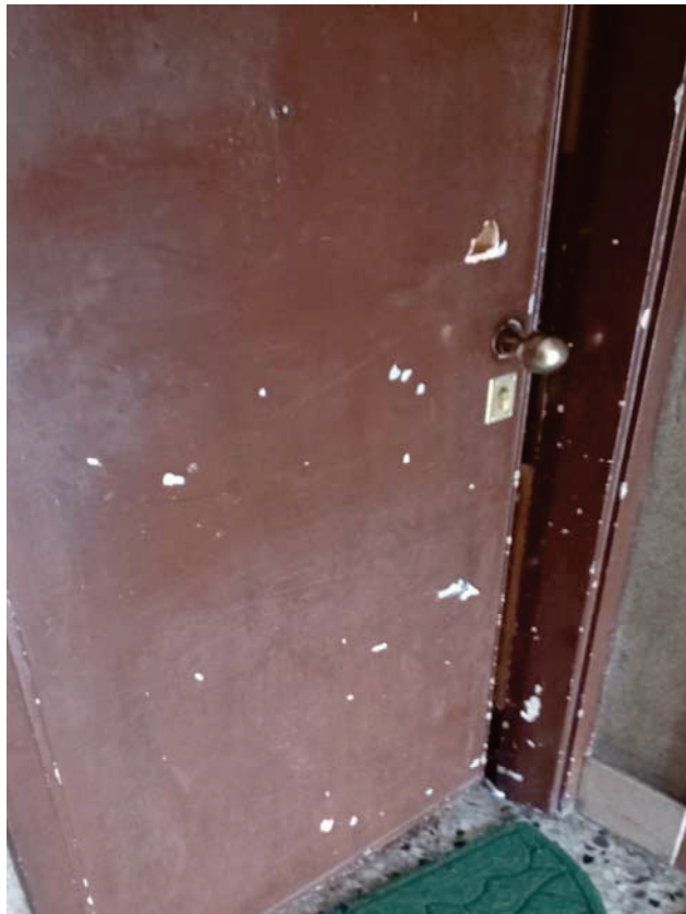
Porta accesso unità: vista dall'esterno
