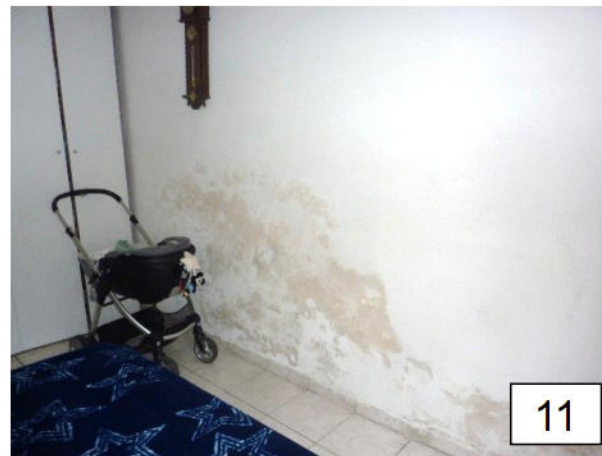
Tracce di umidità (camera da letto)
