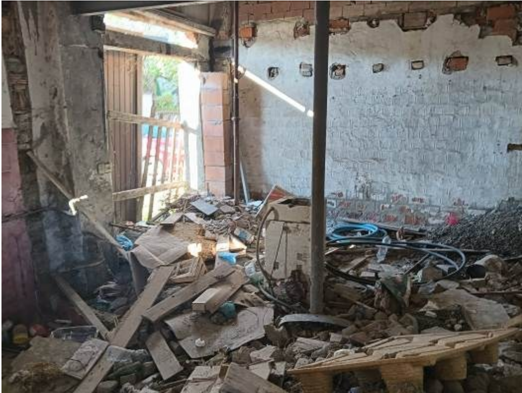
FOTO 6 – locali piano terra
