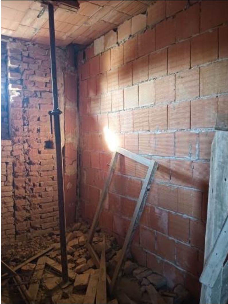
FOTO 11 – locali piano primo
