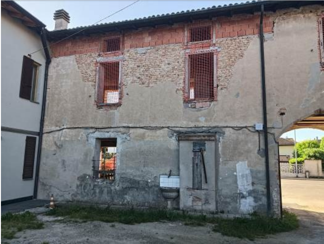
FOTO 4 – vista da cortile interno
