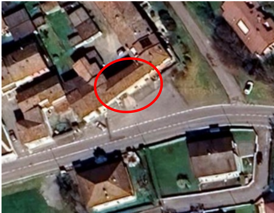
FOTO 2 – particolare vista dall'alto
