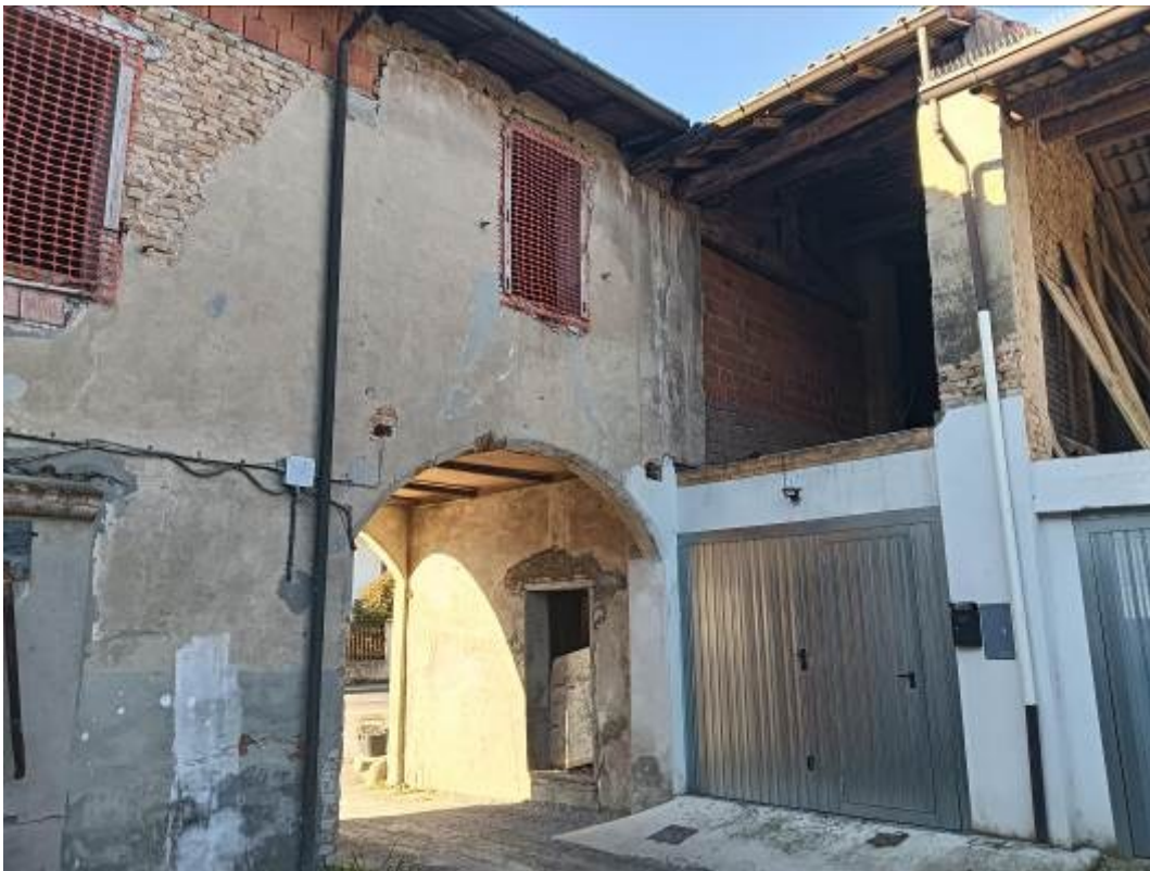
FOTO 5 – vista da cortile interno
