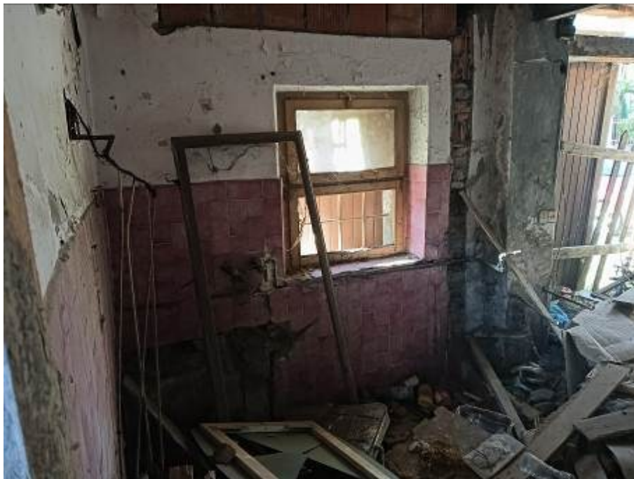
FOTO 7 – locali piano terra
