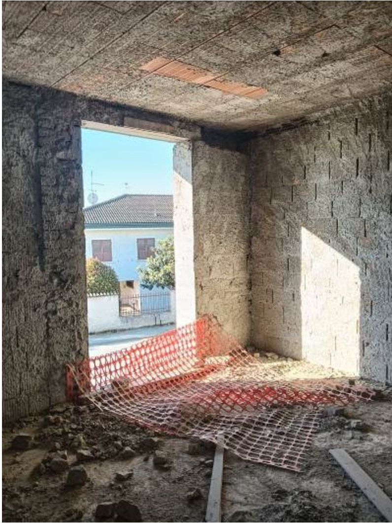
FOTO 9– locali piano primo
