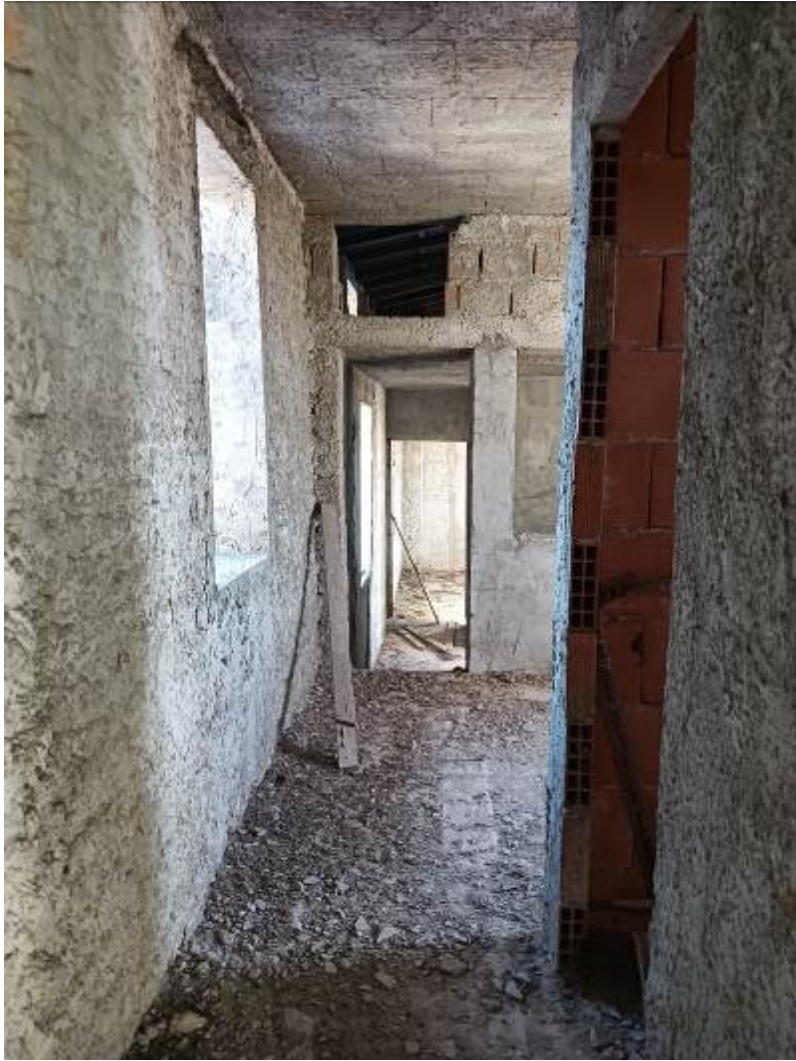
FOTO 10 – locali piano primo
