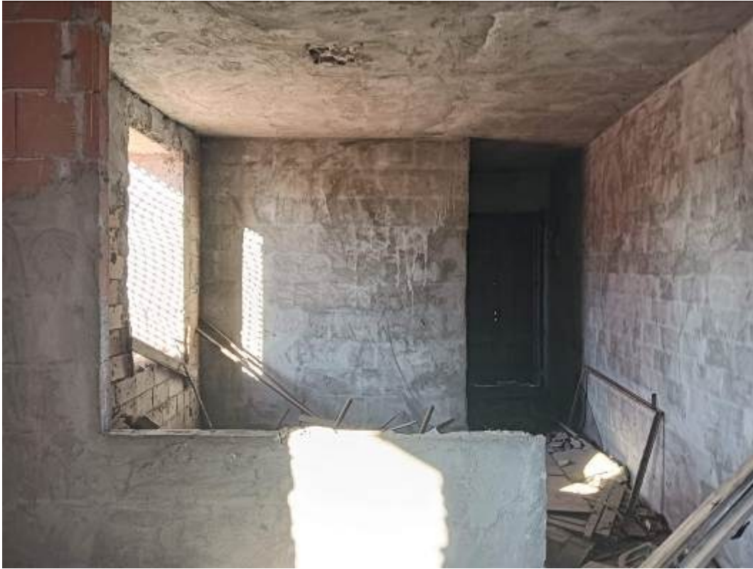
FOTO 8 – locali piano terra
