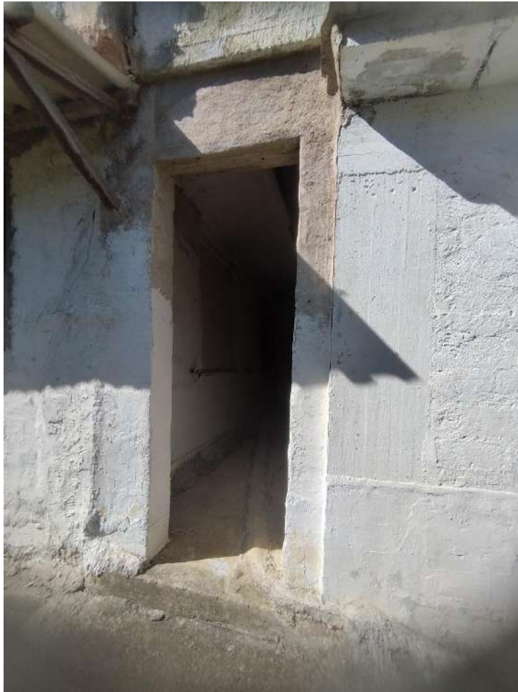
Foto 25) BENE 1 – Intercapedine tra i due corpi di fabbrica
