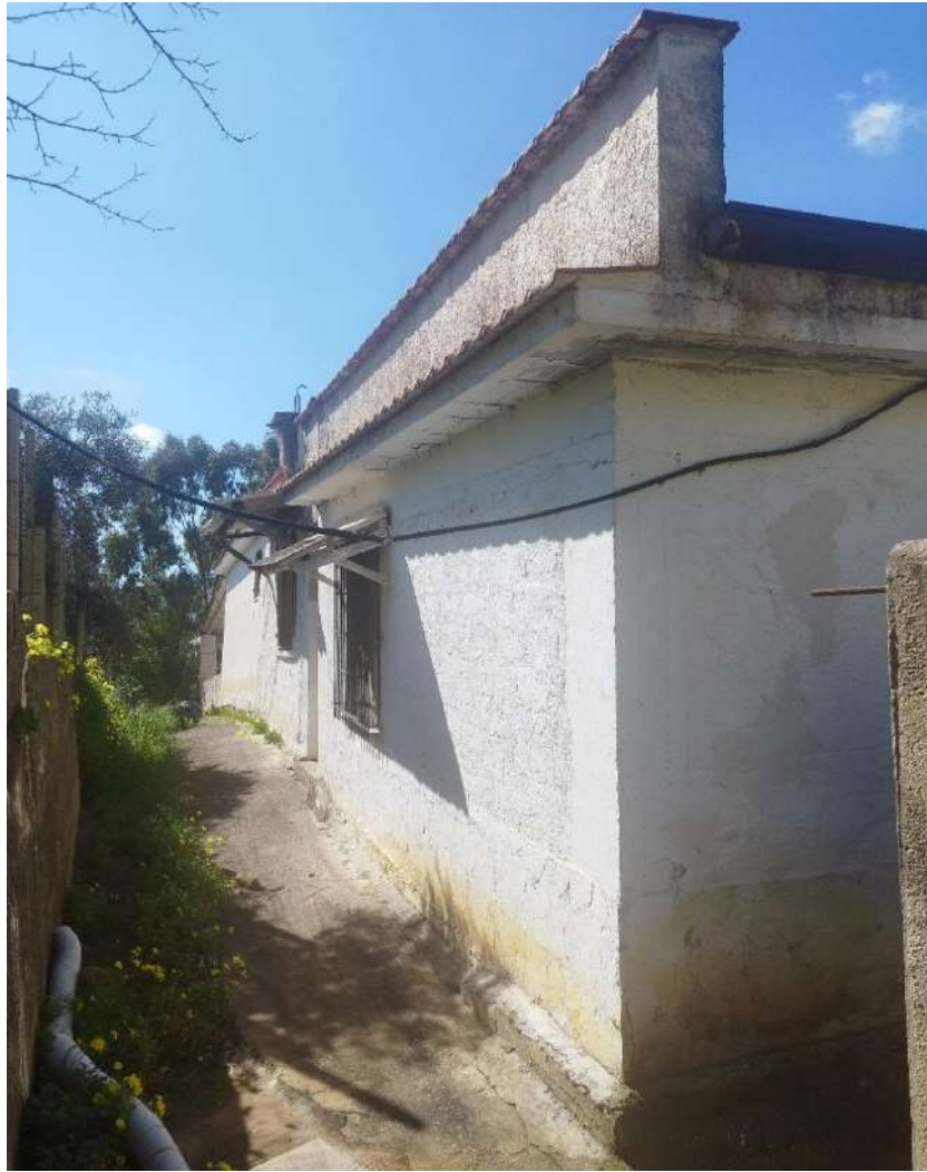
Foto 5) BENE 1 – Prospetto est
