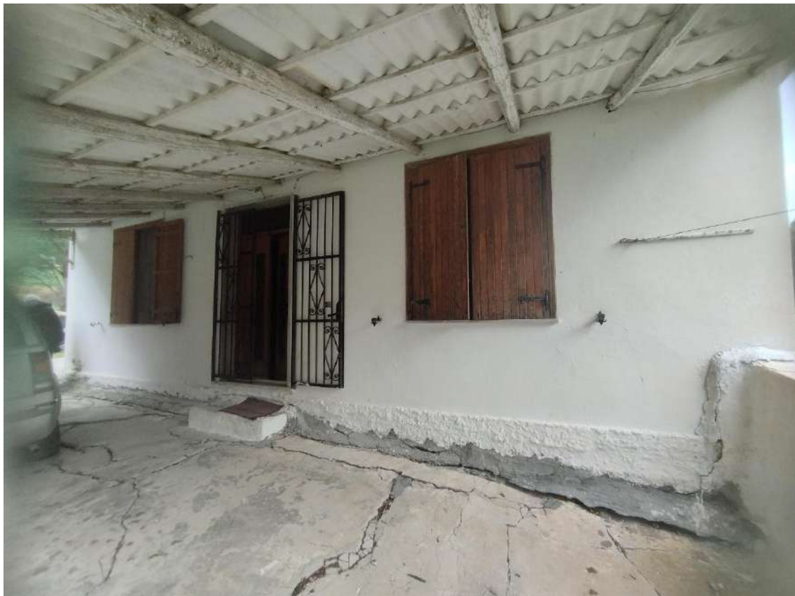
Foto 6) BENE 1 – Vista facciata lato sud
