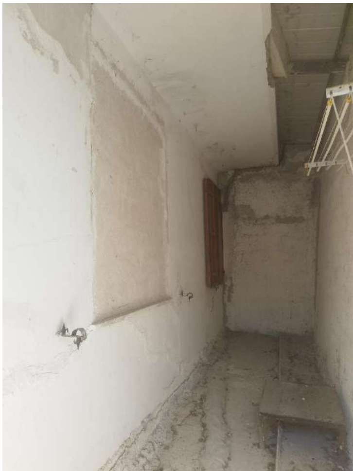
Foto 26) BENE 1 – Interno intercapedine tra i due corpi di fabbrica
