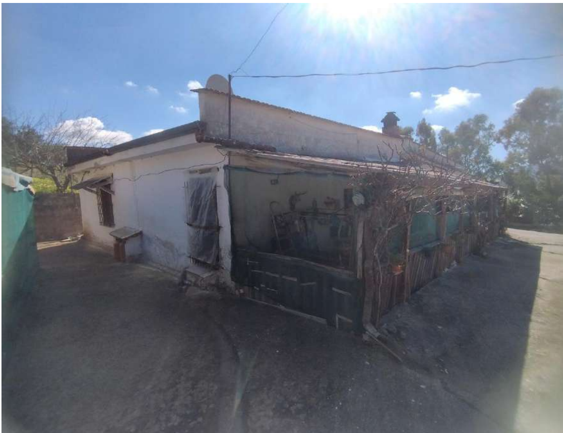
Foto 4) BENE 1 – Vista prospetti nord e ovest
