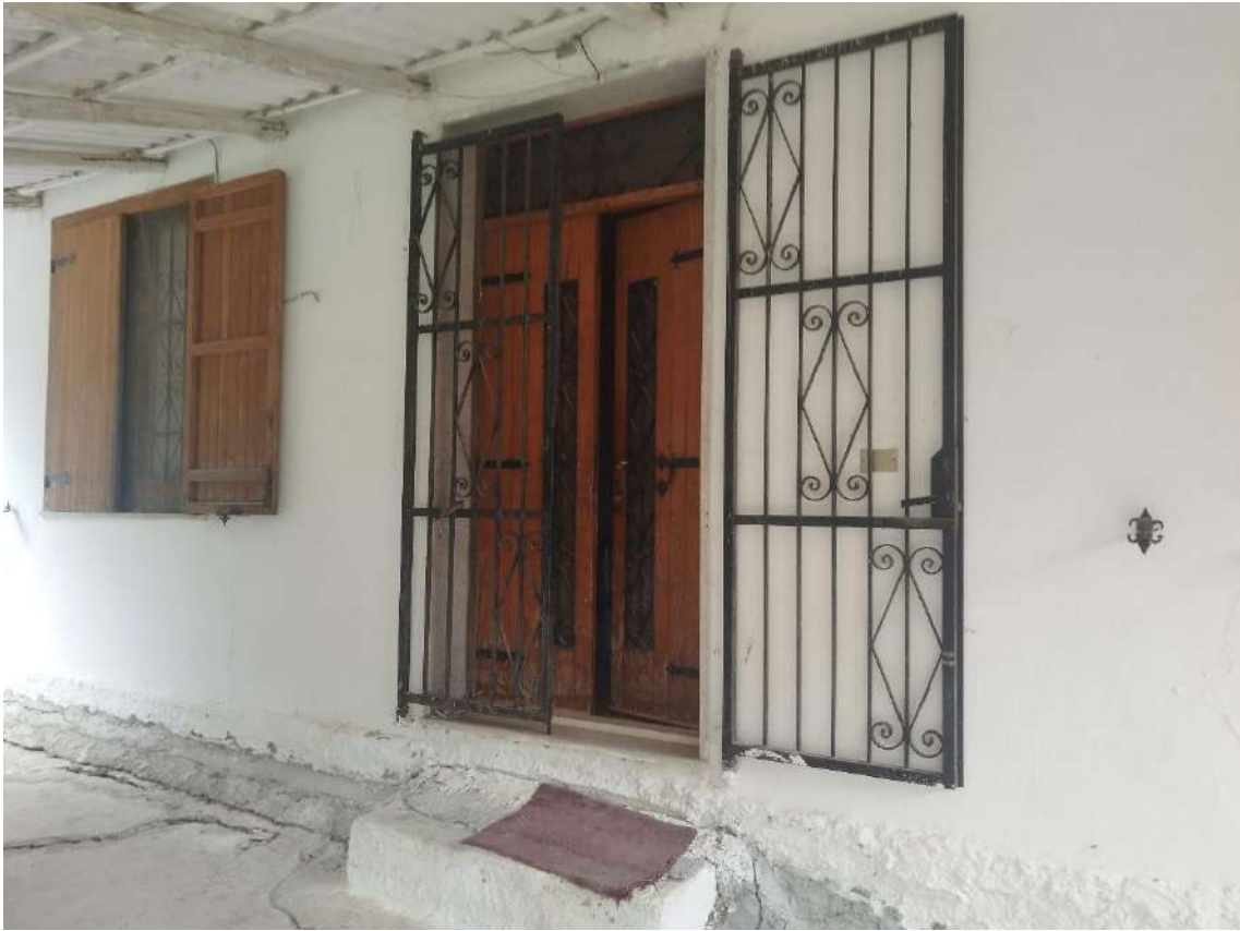
Foto 9) BENE 1 – Unità A – Portoncino d'ingresso
