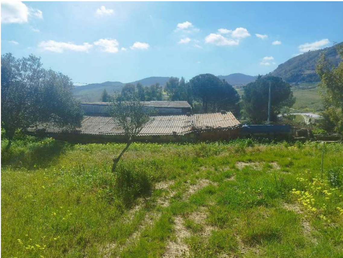
Foto 28) BENE 1 – Deposito attrezzi agricoli (prospetto lato nord e copertura)
