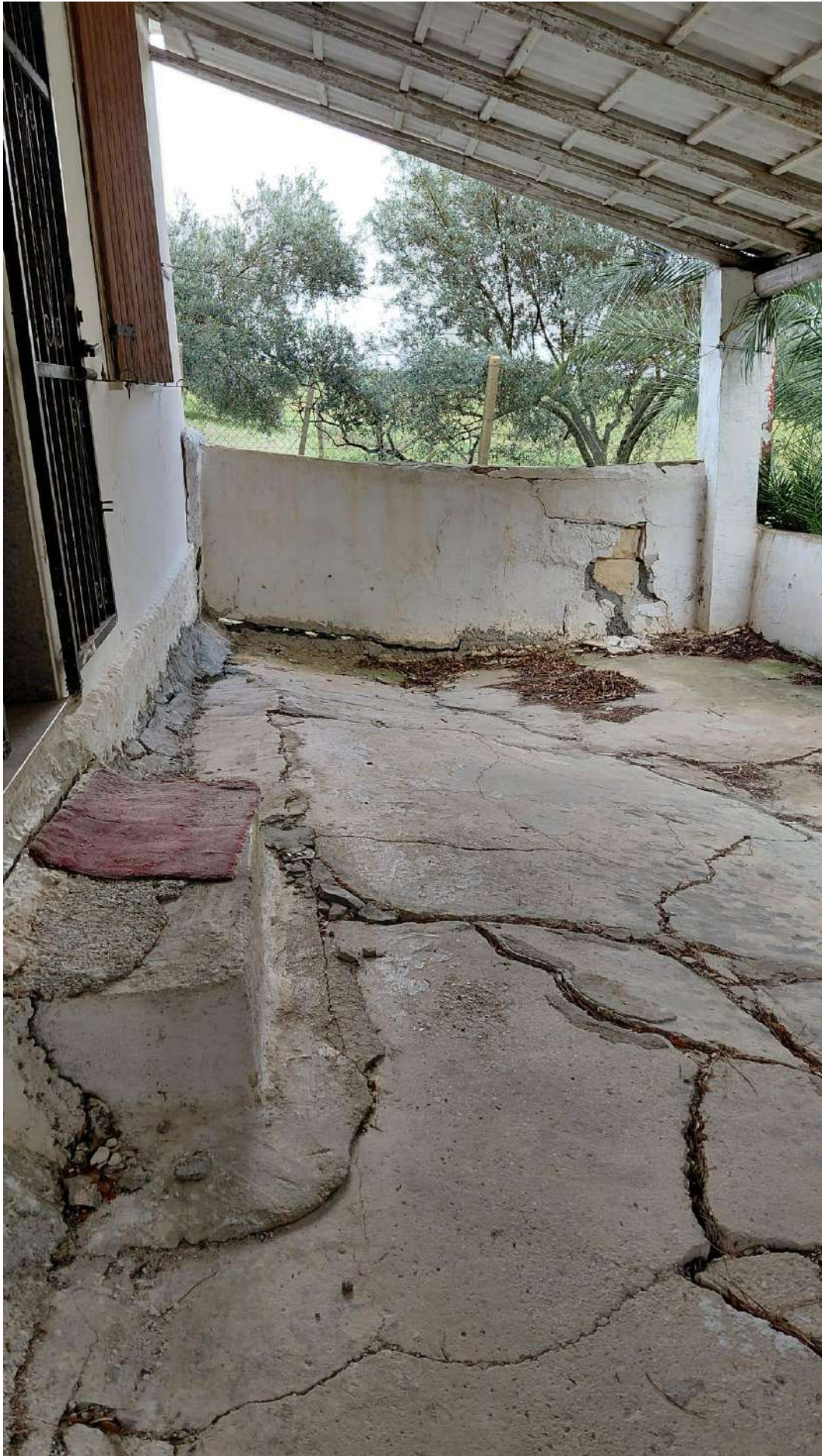
Foto 7) BENE 1 - Vista tettoia lato sud
