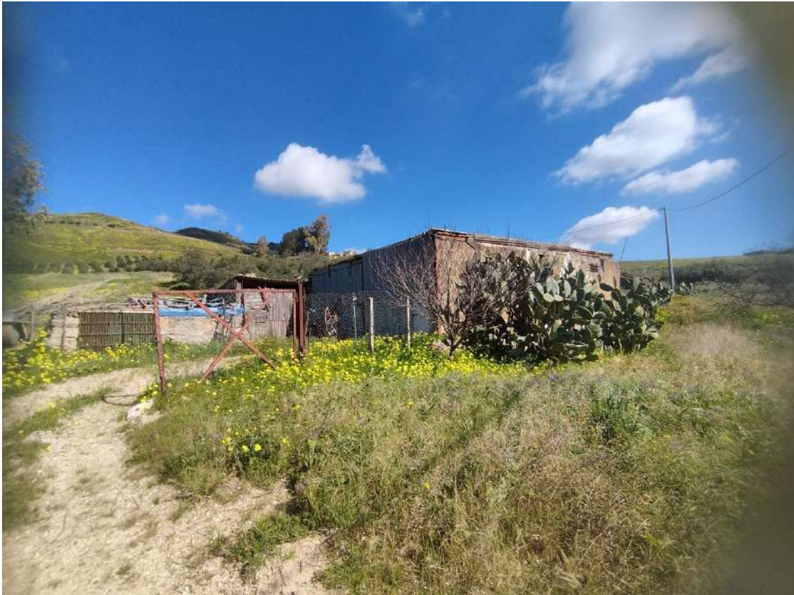
Foto 27) BENE 1 – Deposito attrezzi agricoli (prospetti sud ed ovest)
