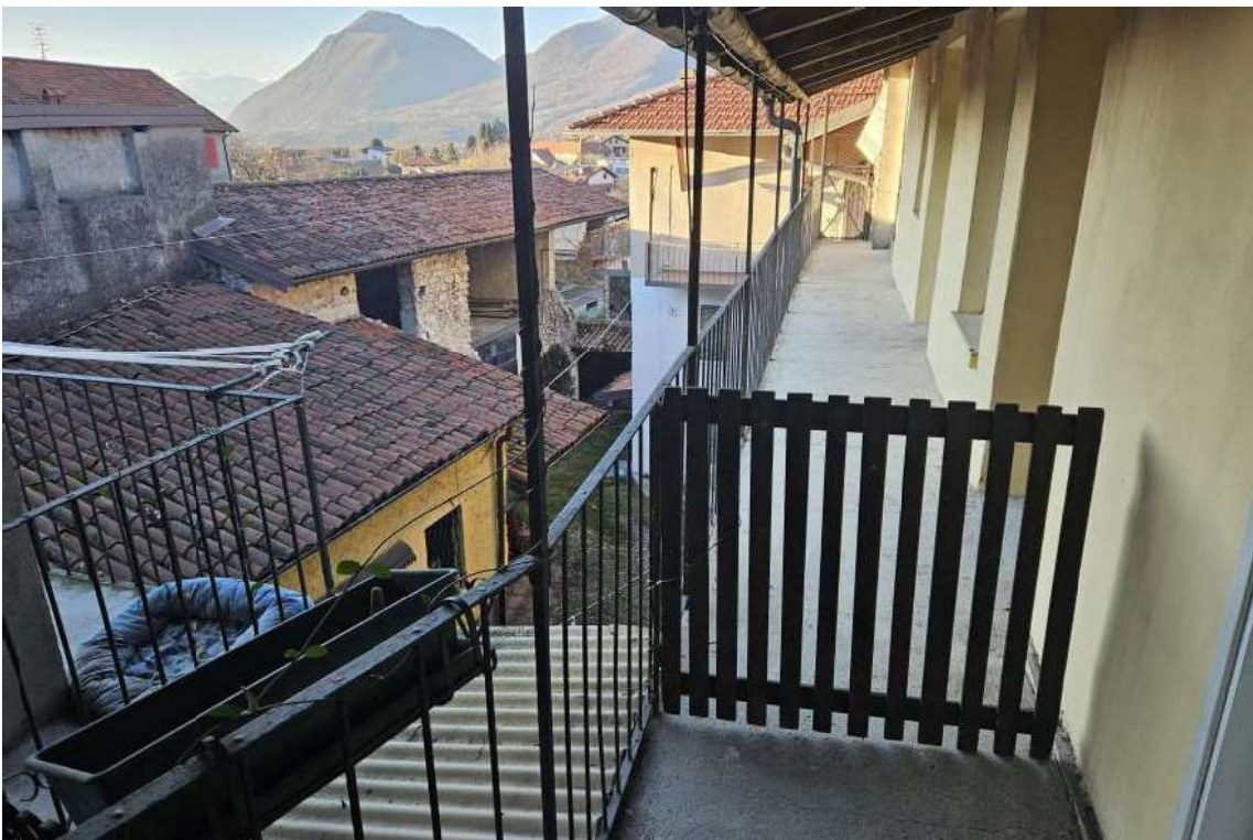
Accesso dal ballatoio comune all'appartamento
