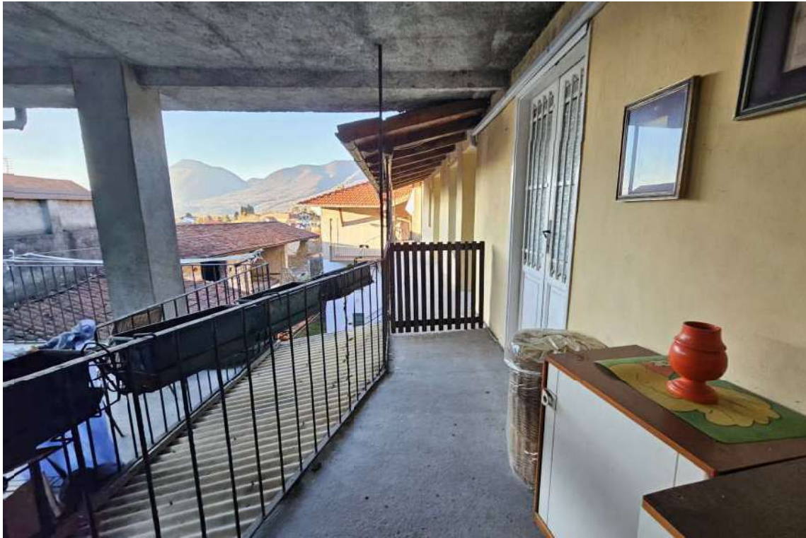
Ballatoio comune d'accesso
