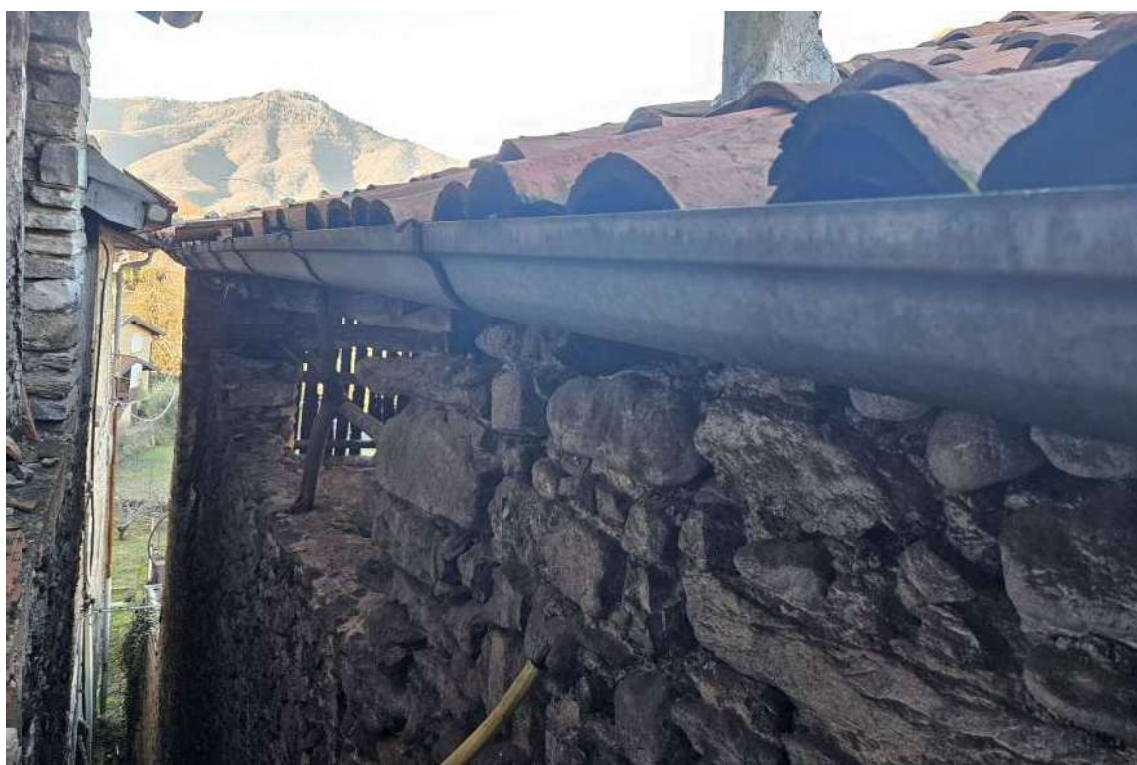
Vista dalla finestra del bagno (trasversale verso valle)
