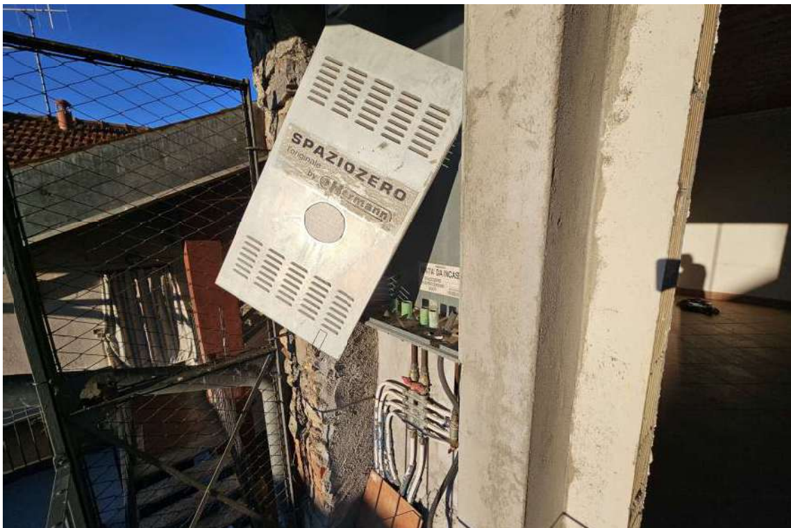
Vano caldaia (vuoto) dell'appartamento
