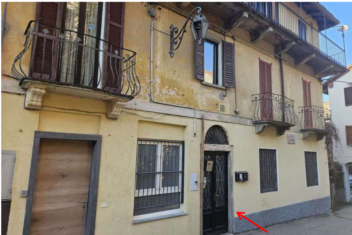
Ingresso al vano scala comune per accesso all'appartamento
