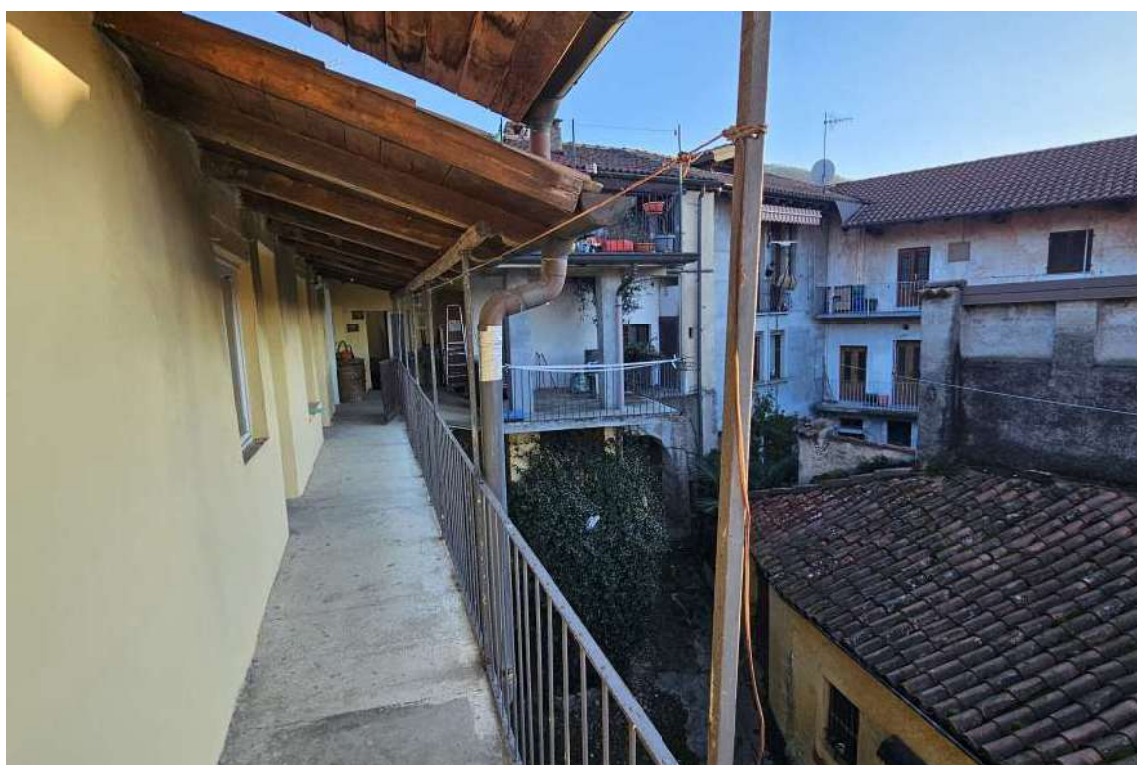
Vista dal balcone esterno alla camera doppia verso la corte
