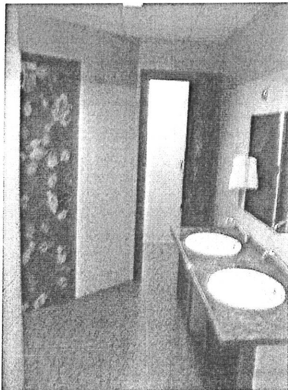
FOTO 5-6 – Vista bagni e ripostiglio
