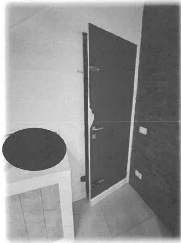
Immagine n. 16: porta di collegamento con la cantina
