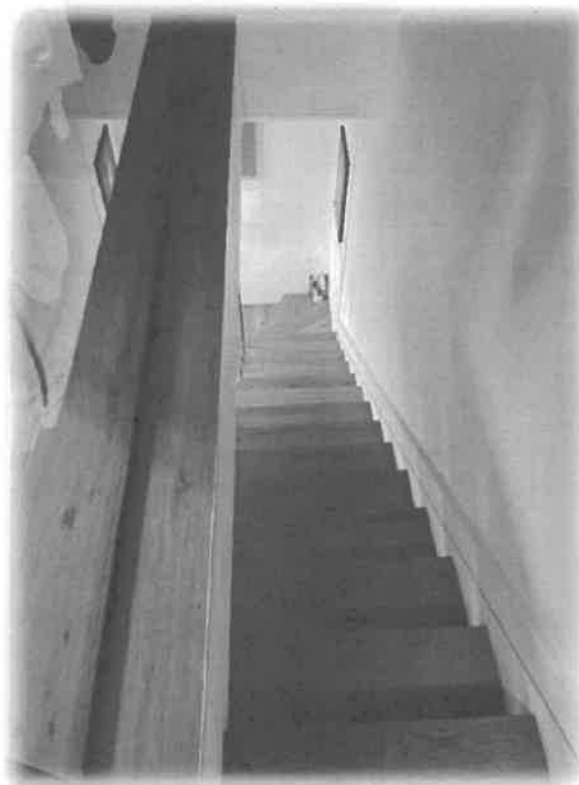
Immagine n. 18: apertura solaio
