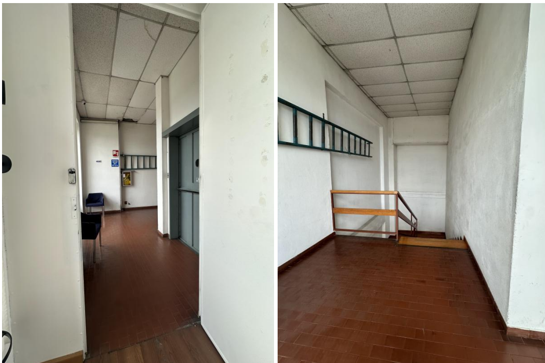
Particolare vano scala comune
