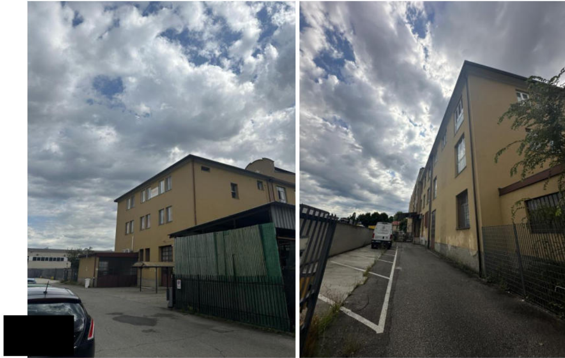
Particolare esterno edificio
