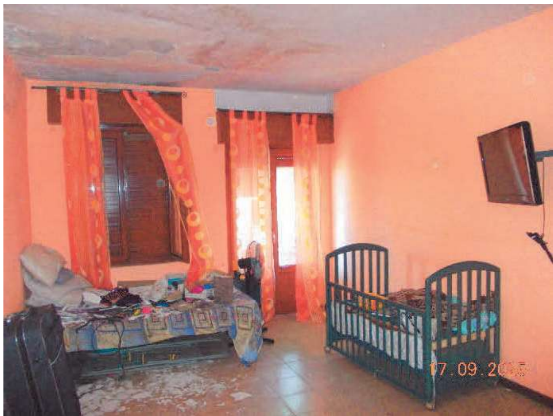
Vista seconda camera e accesso al relativo balcone
