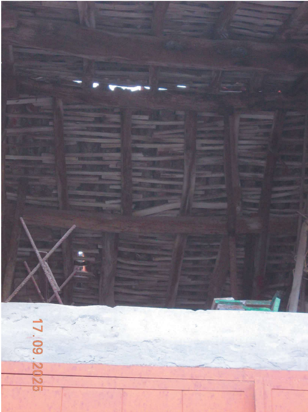
Vista locale sgombero al P.1°
