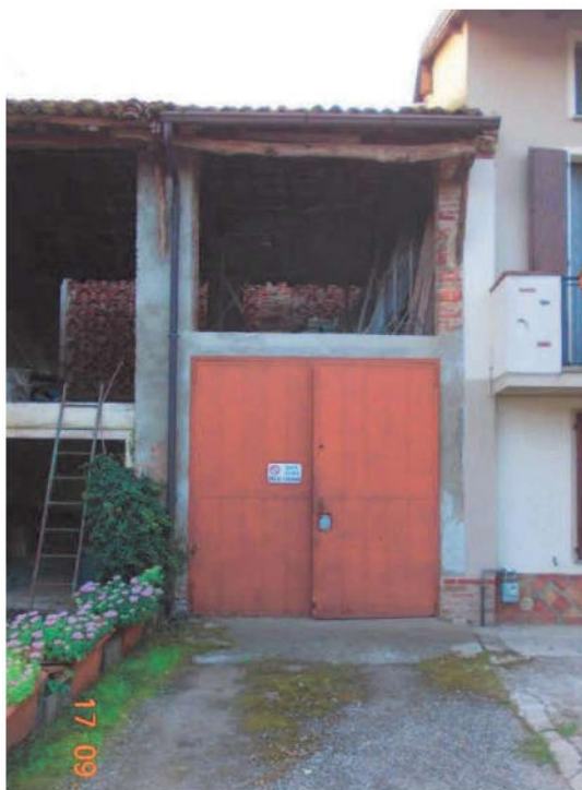
Vista fronte nord autorimessa e locale sgombero al P.1°
