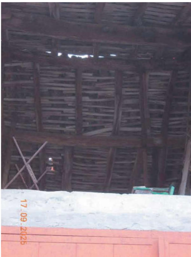
Vista locale sgombero al P.1°
