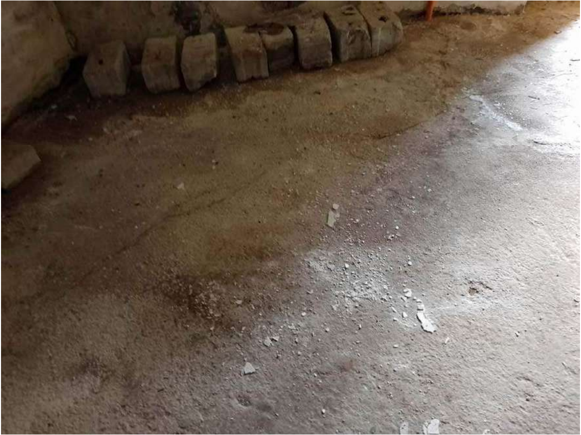
Foto 141 – Vista Interna – pavimentazione interna
