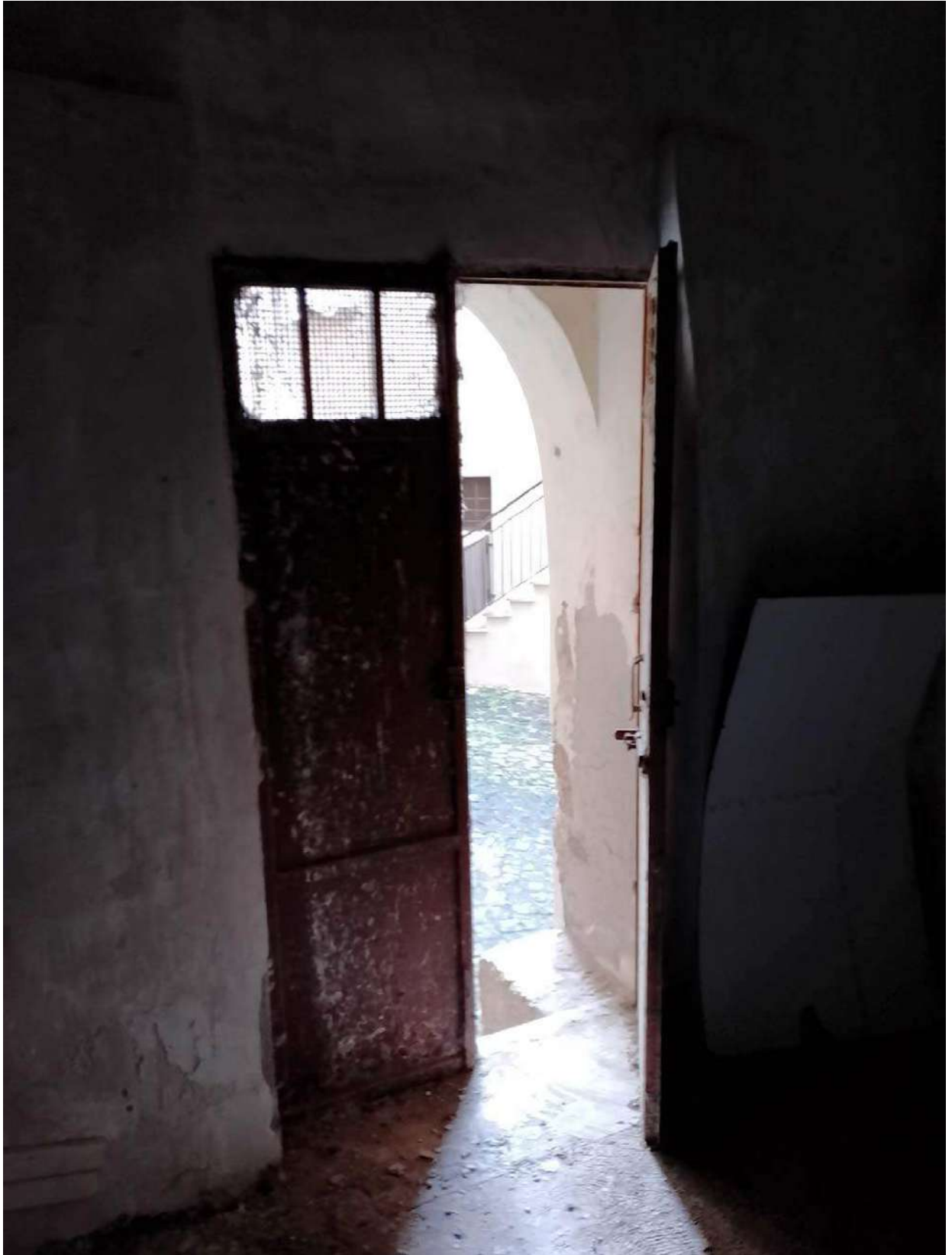
Foto 135 – Vista Interna – portone ingresso
