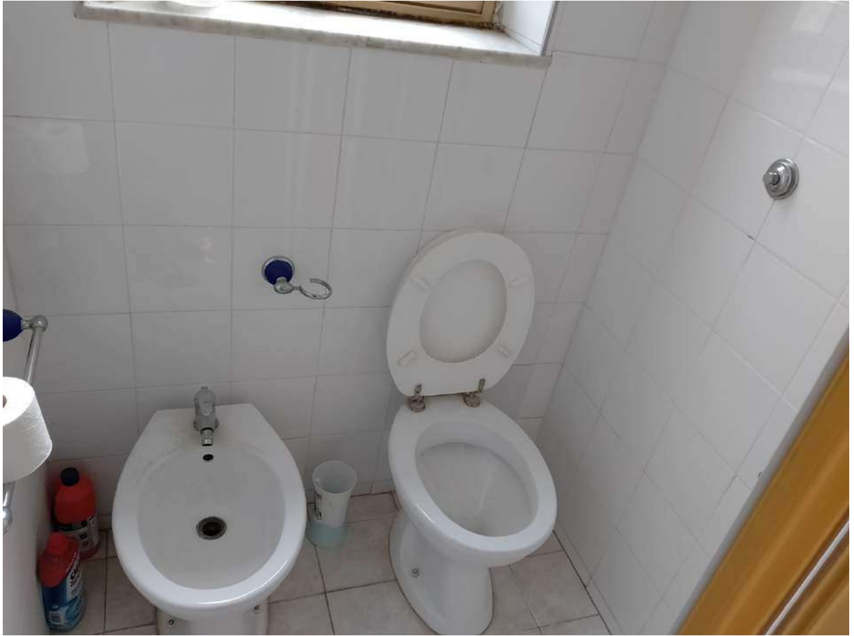
Foto 65 – Vista Interna – bagno
