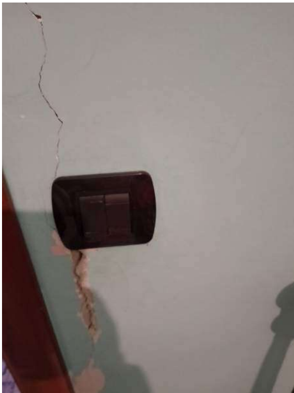
Foto 76, 77 – Vista Interna – lesioni e infiltrazioni
