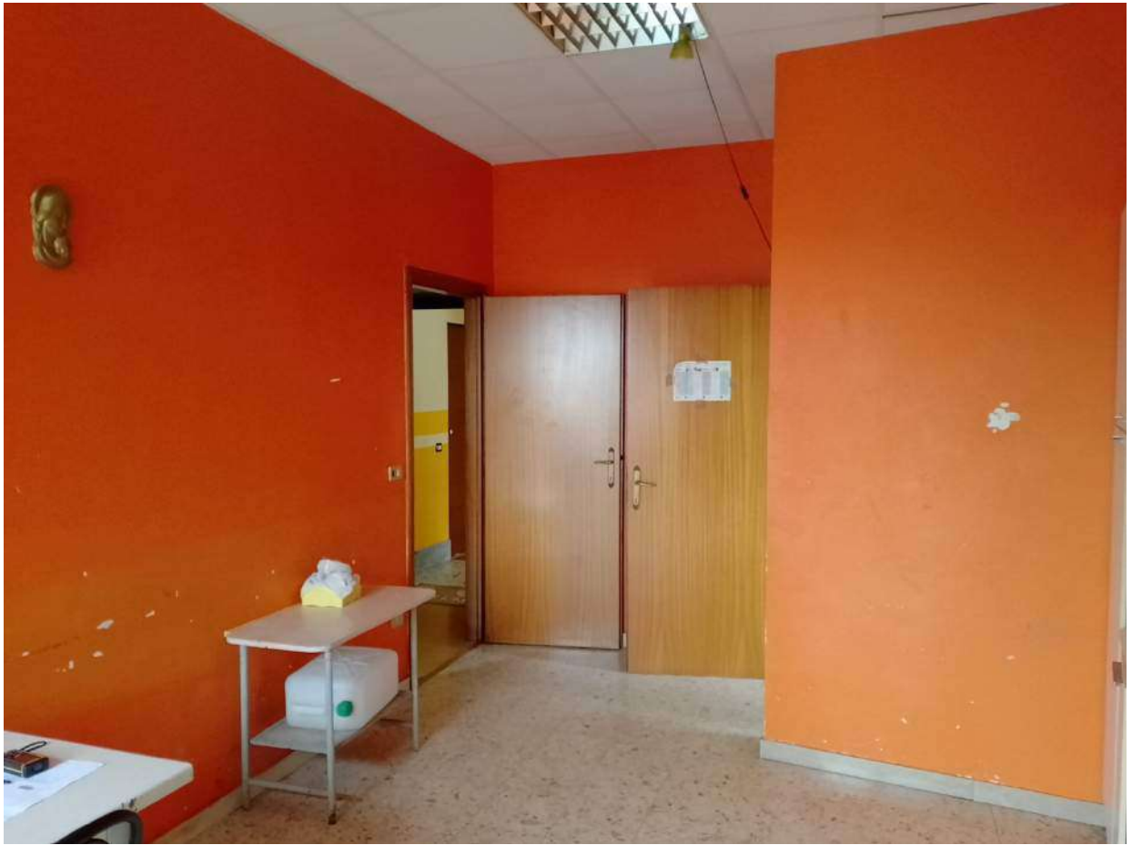
Foto 81 – Vista Interna – ingresso / soggiorno
