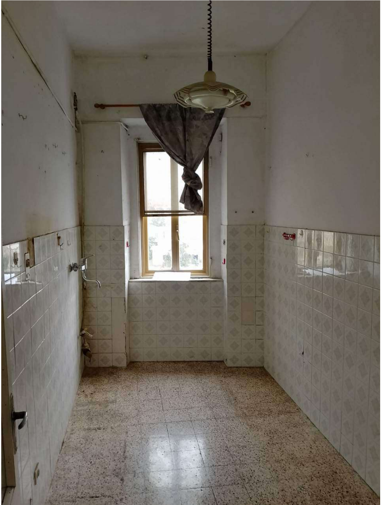
Foto 40 – Vista interna – cucina
