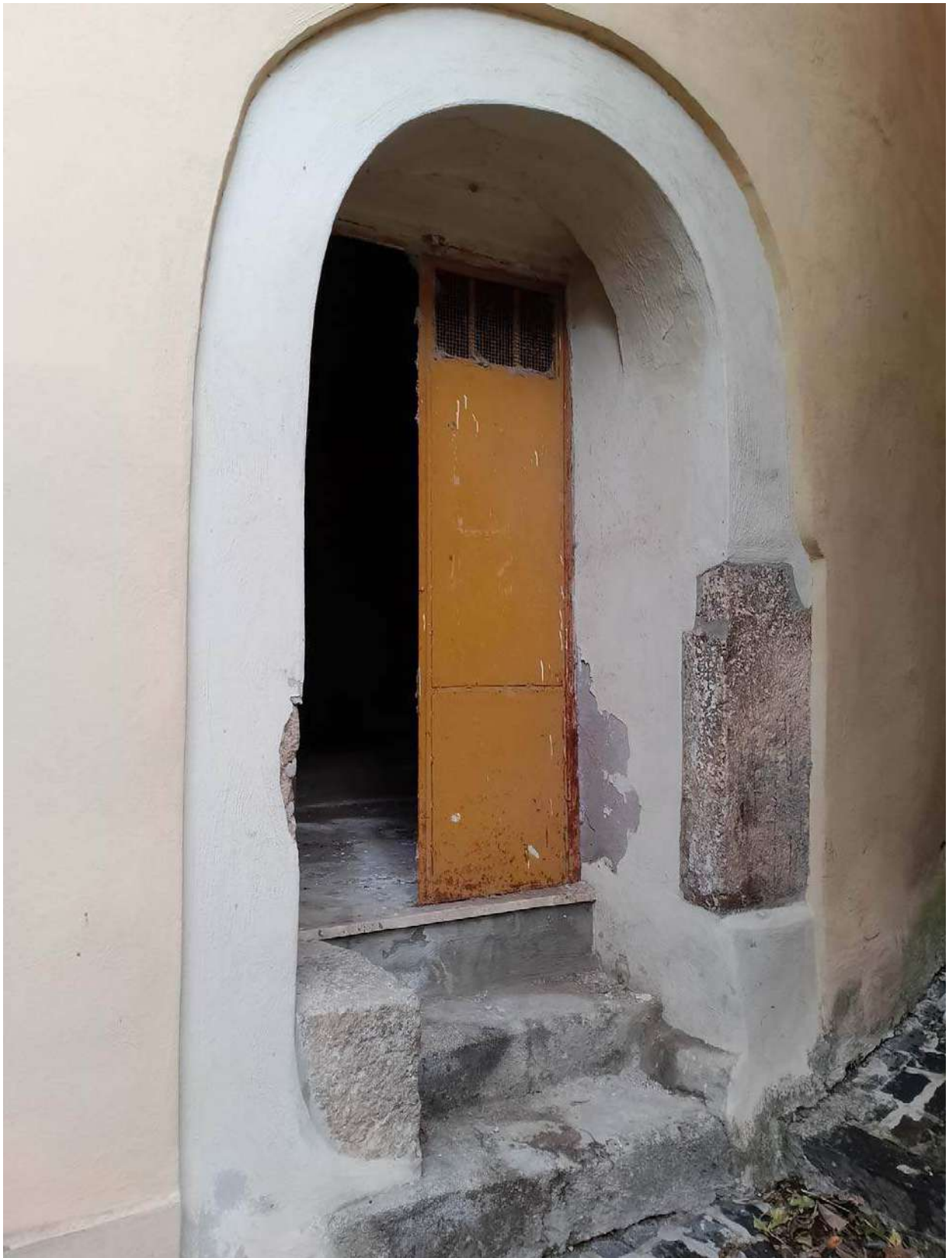
Foto 134 – Vista esterna – portone ingresso
