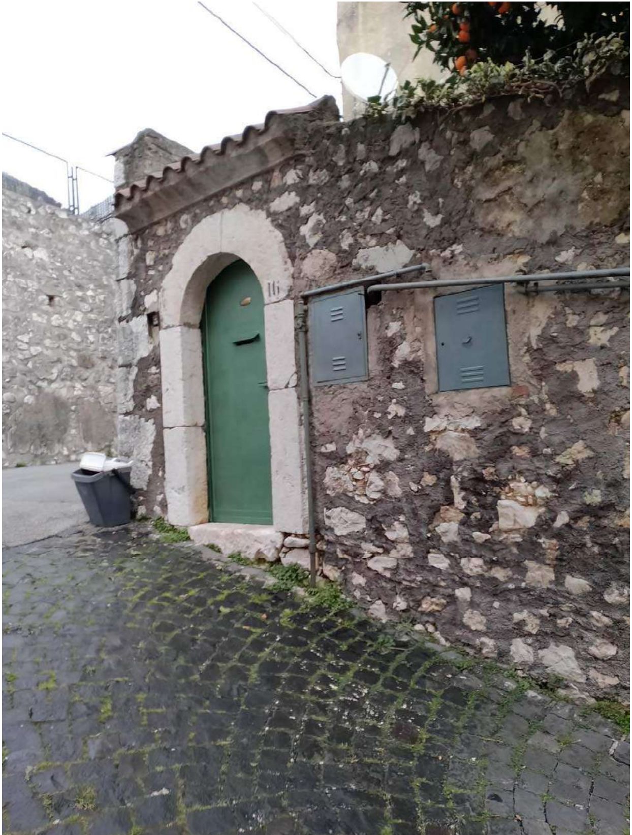
Foto 99A - Vista esterna – ingresso via Lucenteforte
