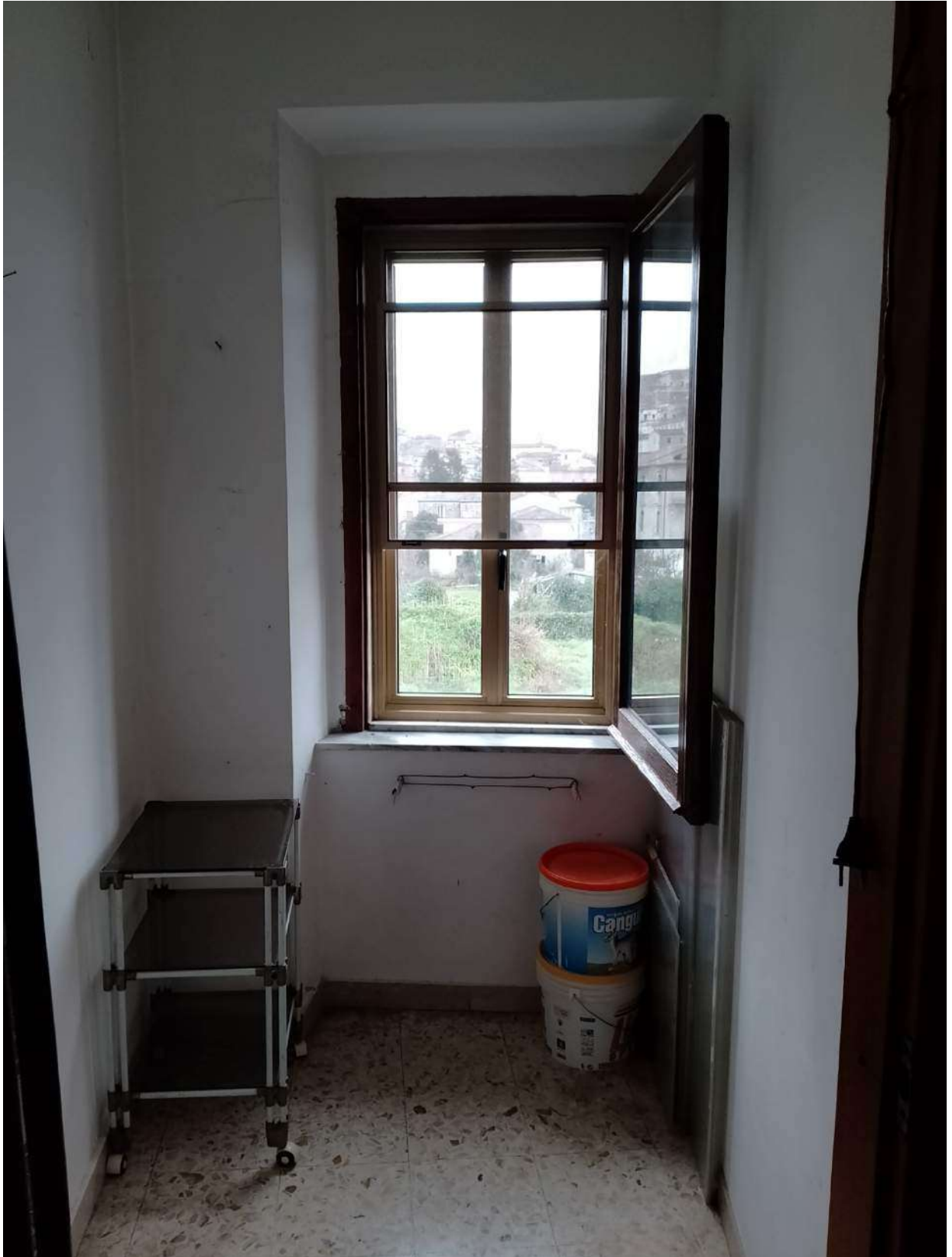
Foto 84 – Vista Interna – ripostiglio
