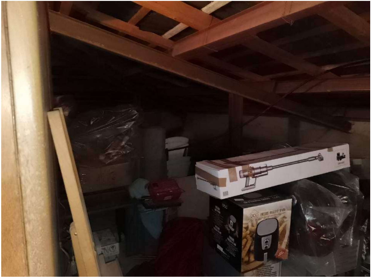
Foto 115 – Vista Interna – sottotetto
