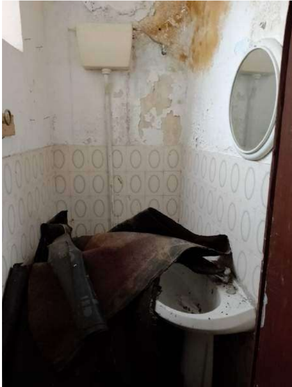
Foto 26, 27 – Vista interna – bagno - infiltrazioni
