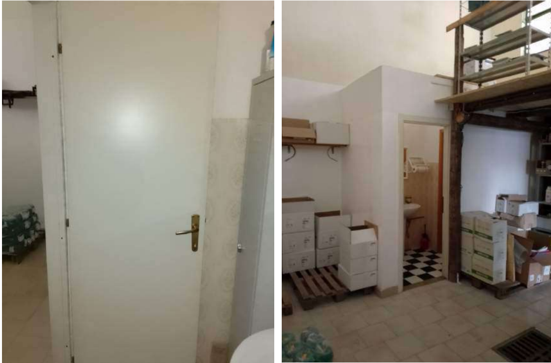
Foto 7, 8, 9, 10, 11, 12 – Vista interna dell'immobile - bagno
