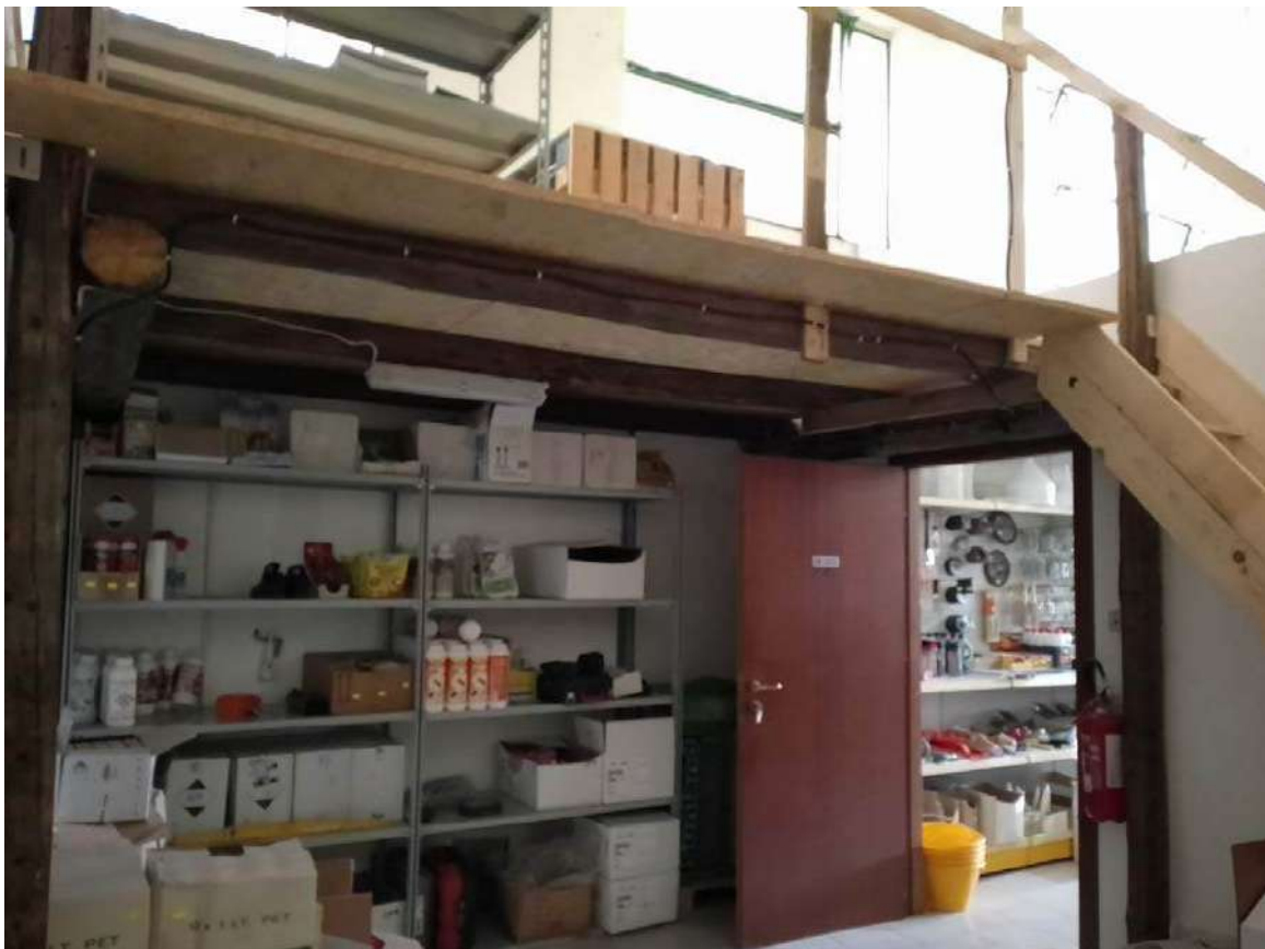
Foto 13 Vista interna - soppalco
