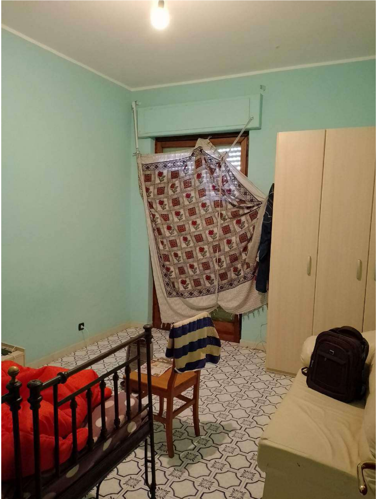
Foto 61 – Vista Interna – camera
