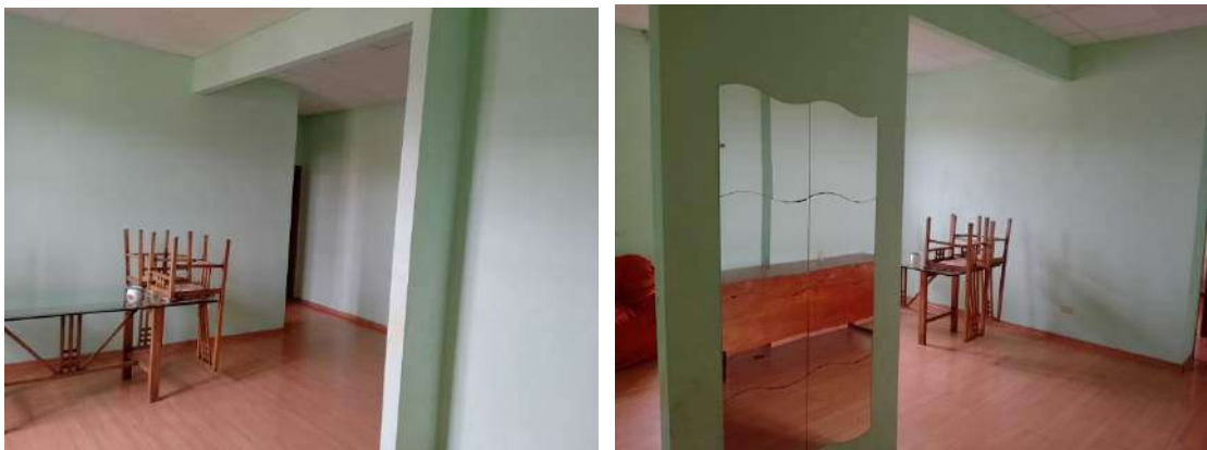
Foto 82, 83 – Vista Interna – ingresso / soggiorno
