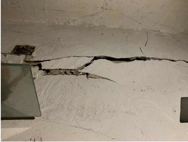
Foto n. 4 – fessurazione tipo
