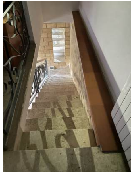
Foto n. 19 – Vista vano scala
