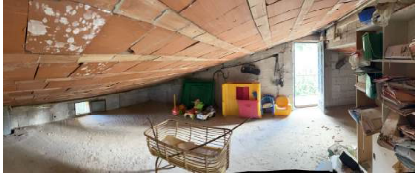
Foto n. 24 – Vista secondo piano sottotetto
