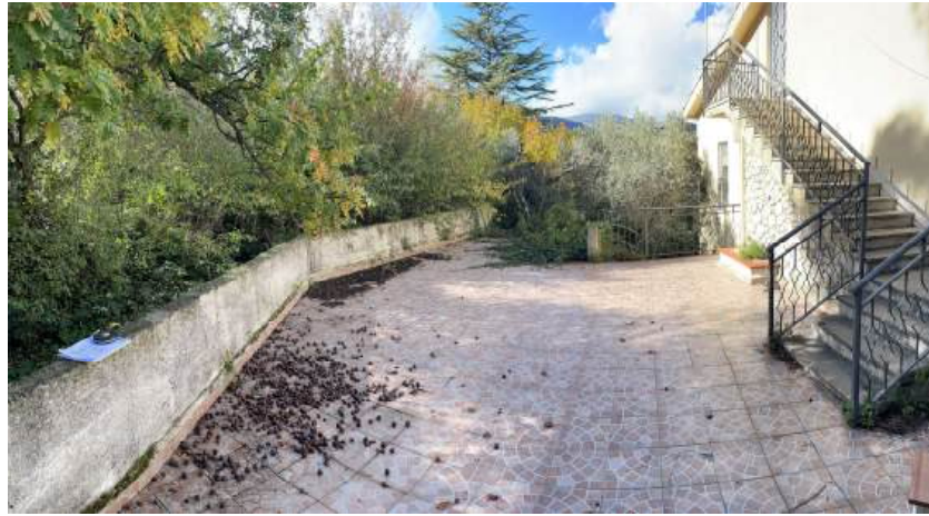
Foto n. 8 – Vista corte esterna piano primo
