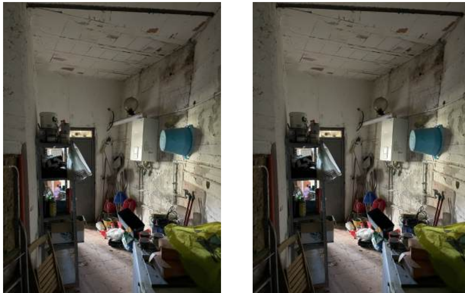
Foto n. 26 - 27 – Vista vano/ locale tecnico piano terra
