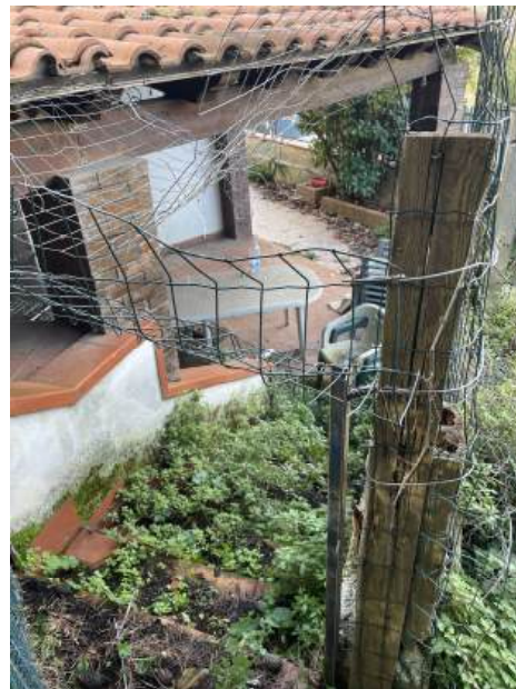
Foto n. 7 – Vista scala esterna
