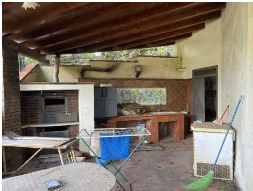
Foto n. 13 – Vista forno in muratura
