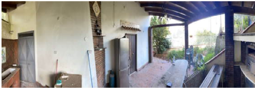
Foto n. 12 – Vista porticato esterno
