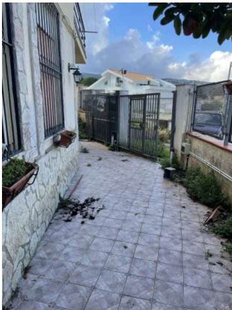
Foto n. 6 – Vista ingresso da corte esterna
