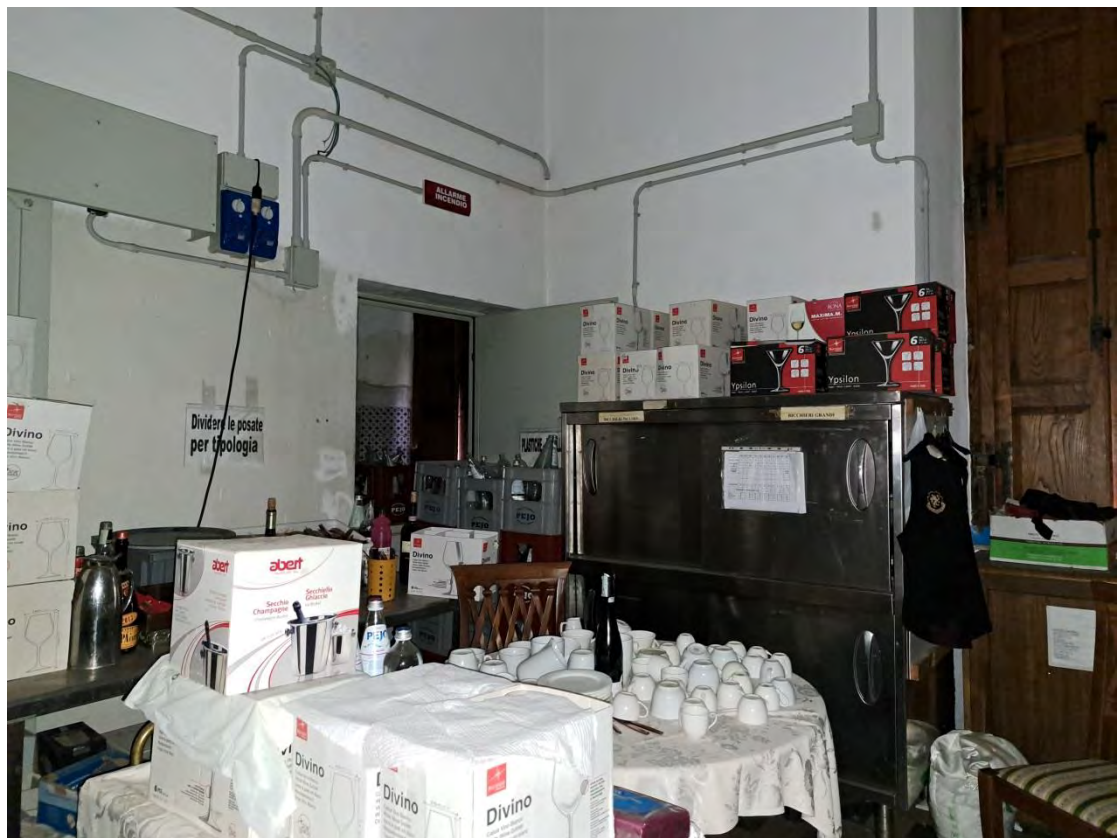
FOTO 14 (PIANO TERRA: cucina)
