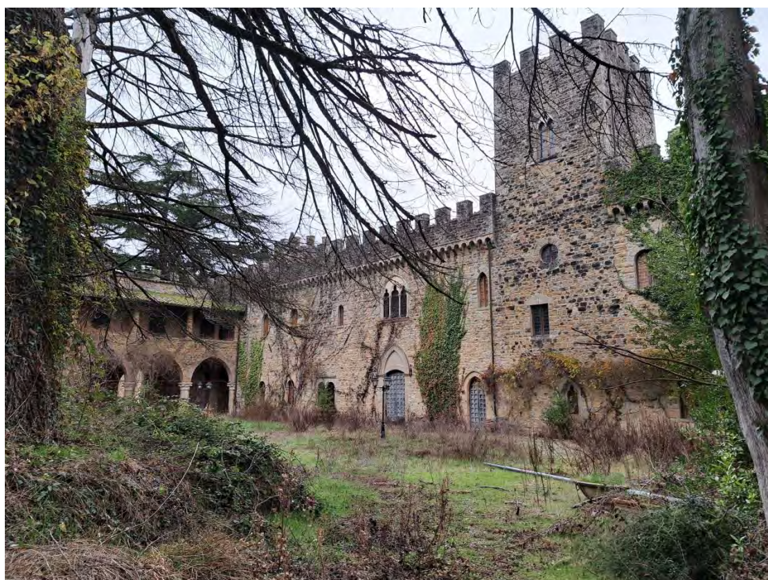
FOTO 4 (Castello dell'Oscano, vista da monte)
