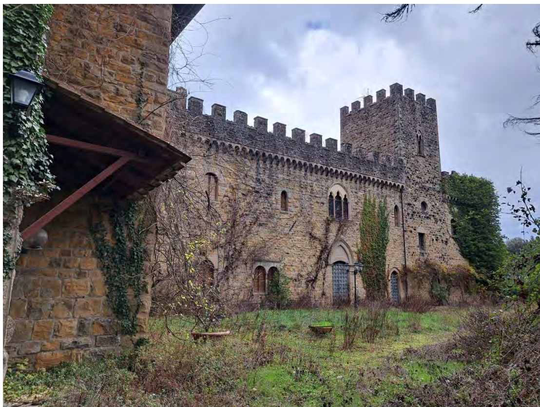
FOTO 3 (Castello dell'Oscano, vista da monte)
