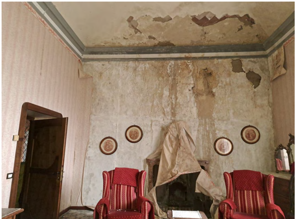
FOTO 24 (PIANO PRIMO: camera)
