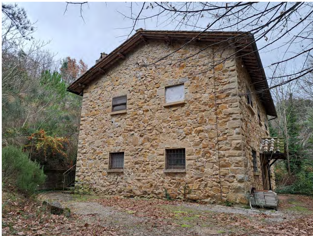
FOTO 39 (CASA DEL GIARDINIERE: vista del fronte)
