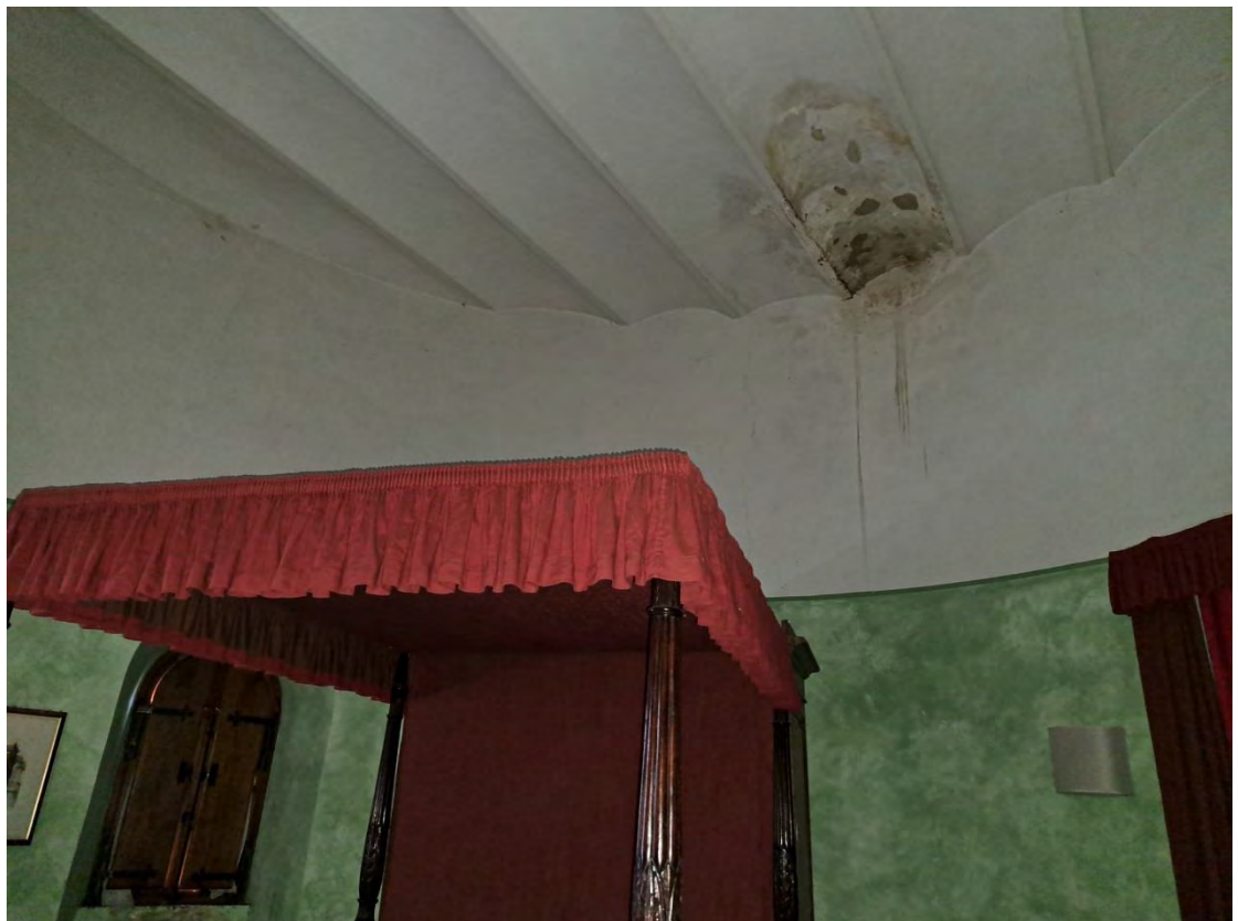
FOTO 30 (PIANO PRIMO: camera)
