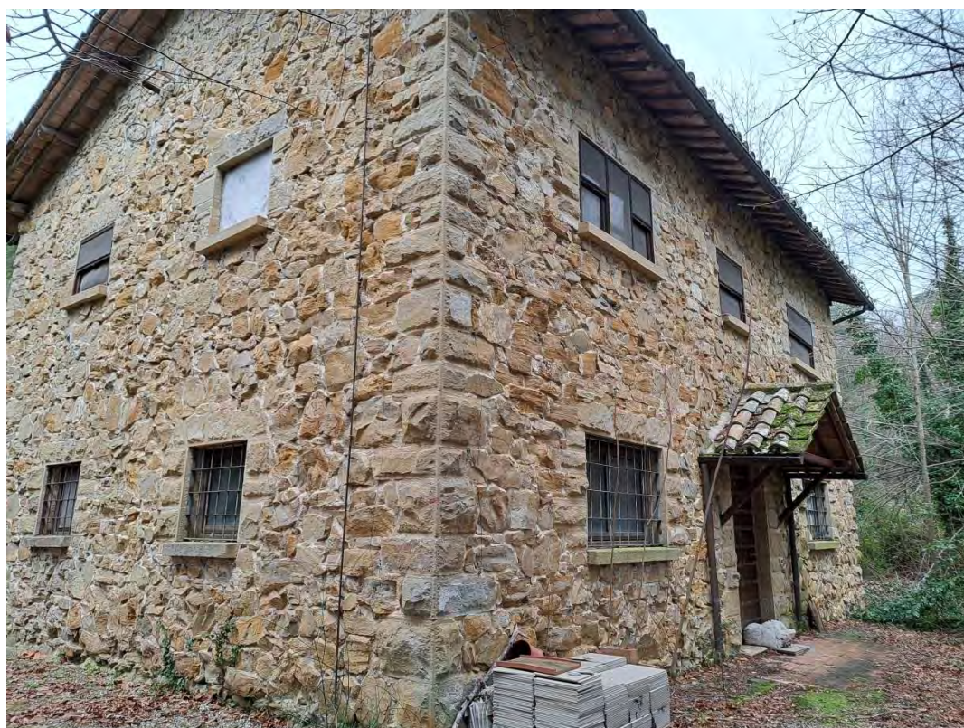
FOTO 40 (CASA DEL GIARDINIERE: vista del fronte)
