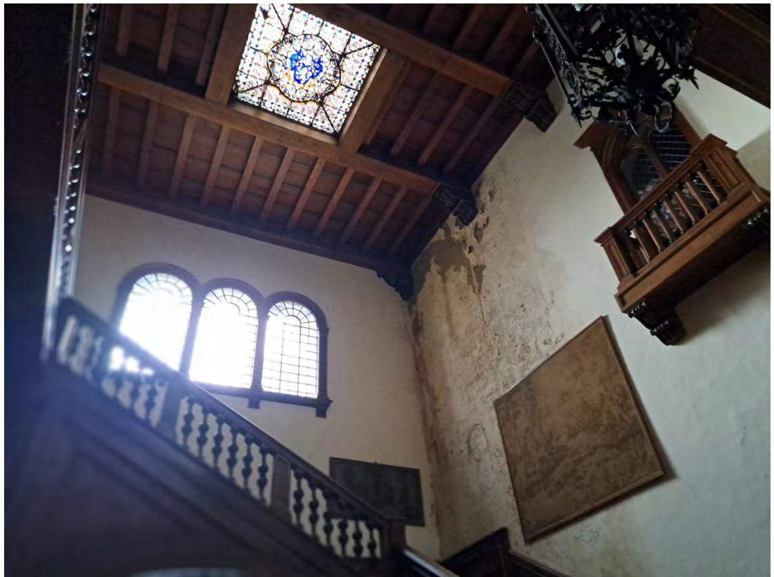
FOTO 8 (PIANO TERRA: salone di ingresso)
