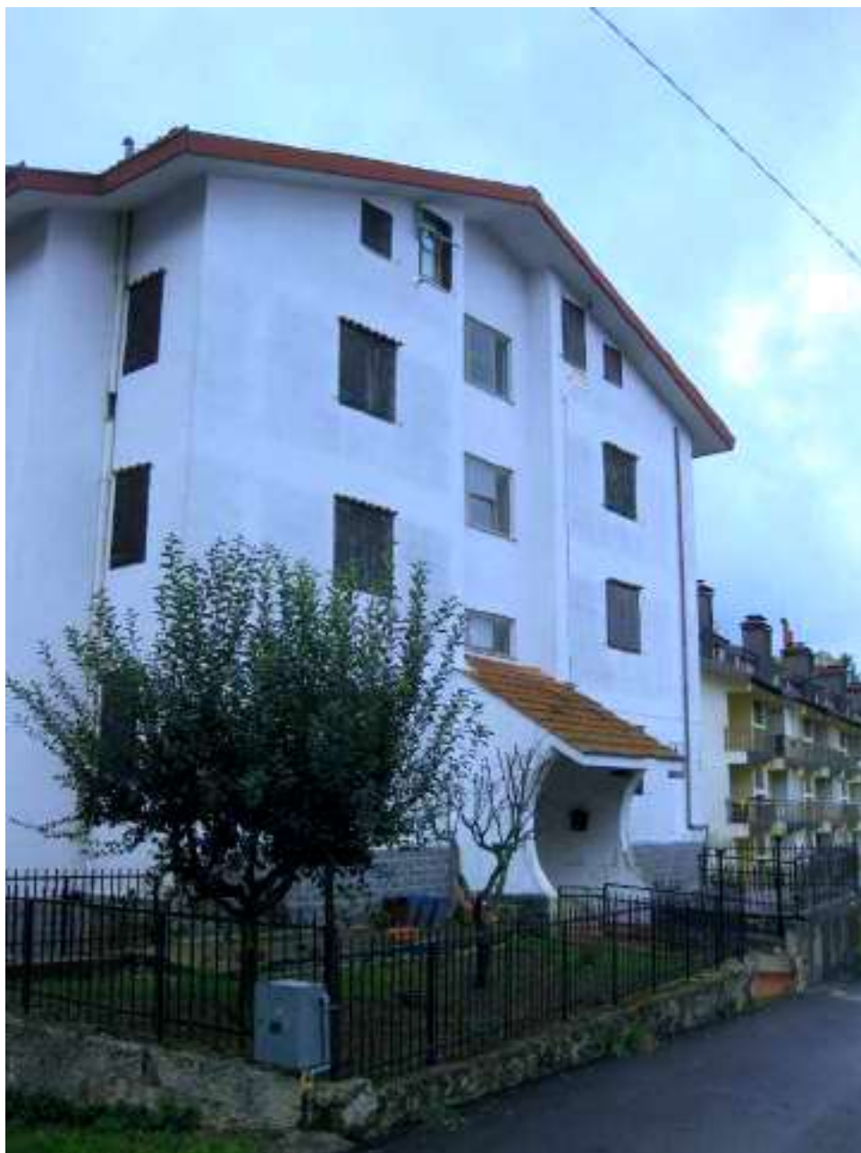
Fabbricato prospetto Nord
