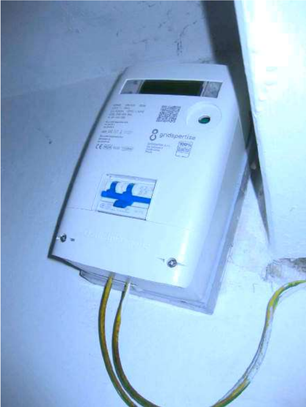
Stato attuale impianto elettrico
