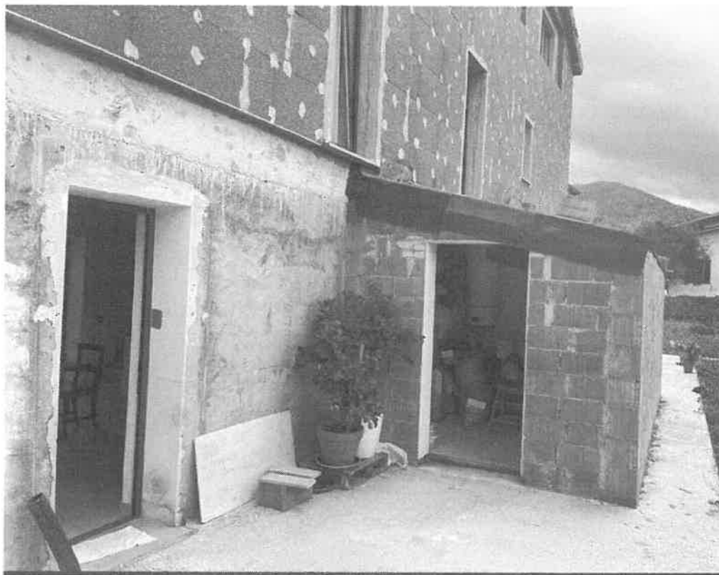
Foto 02 vano tecnico impianti
