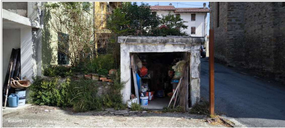
Foto n.6: ingresso box auto
