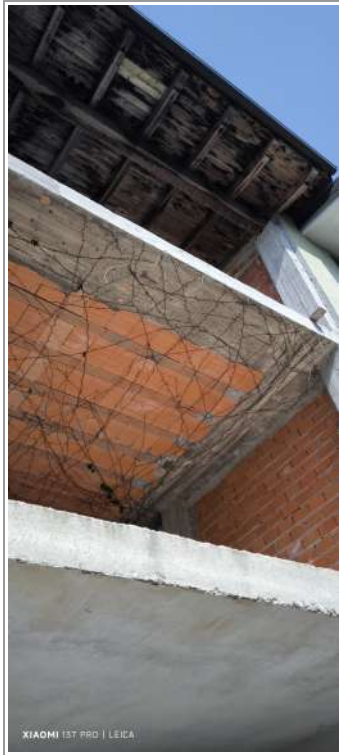
Foto n.4: dettaglio copertura con orditura in legno
