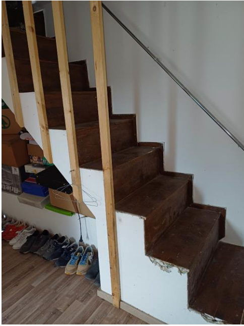
Particolare scala (alzata cm. 25)
