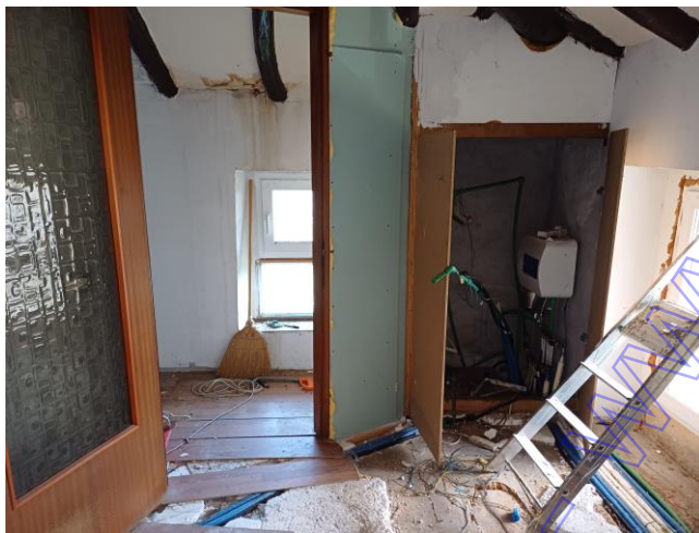
Interni del piano sottotetto
