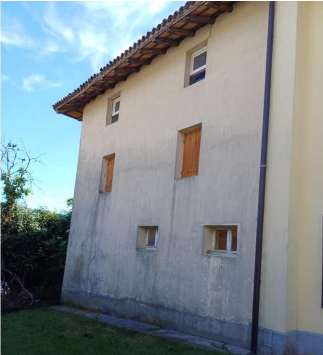
Facciata verso Nord-Nord/Est
