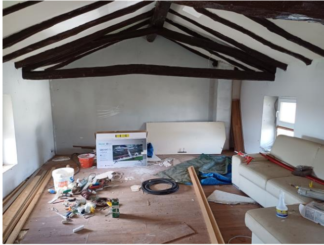
Interni del piano sottotetto
