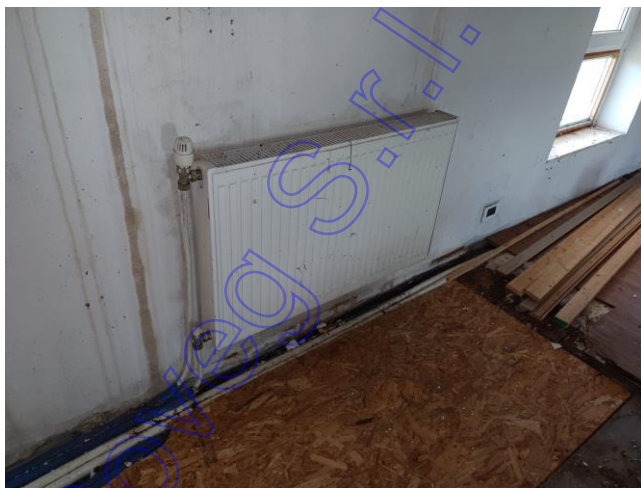
Interni del piano sottotetto
