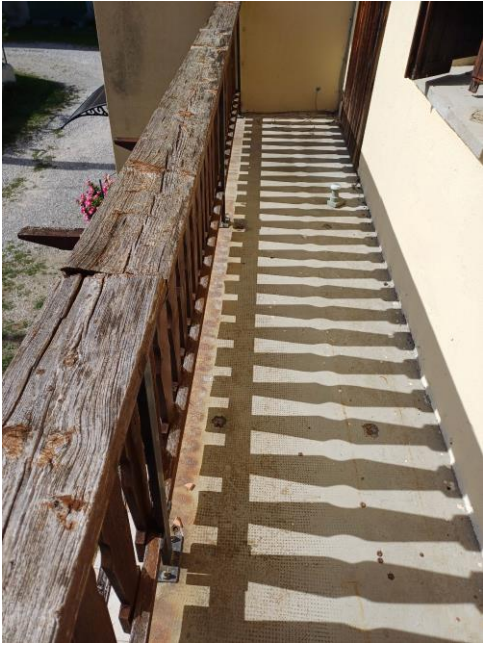
Terrazza primo piano corpo principale
