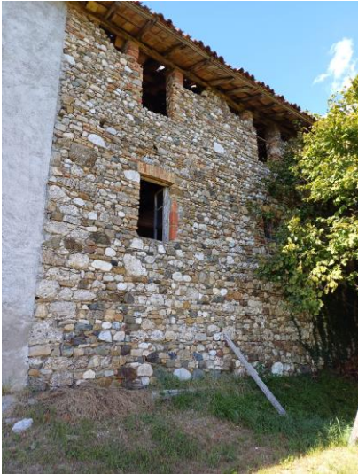
Facciata posteriore del rustico
