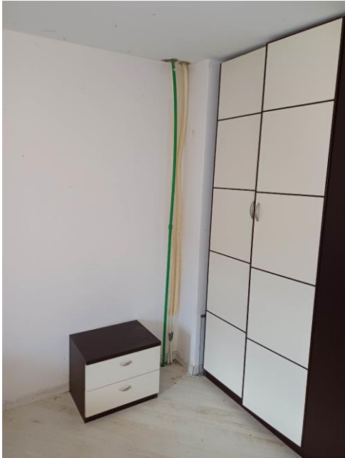
Stanza da letto al primo piano (impianti a vista)
