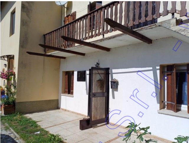
Facciata verso corte
