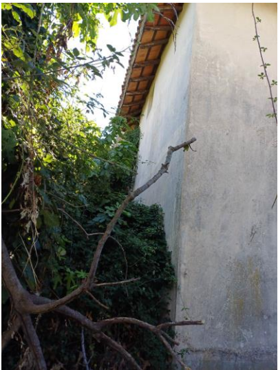
Facciata posteriore del corpo principale
