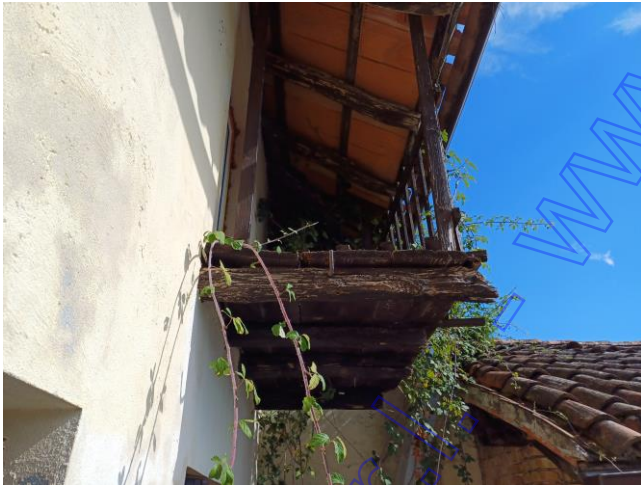
Terrazza sottotetto corpo principale
