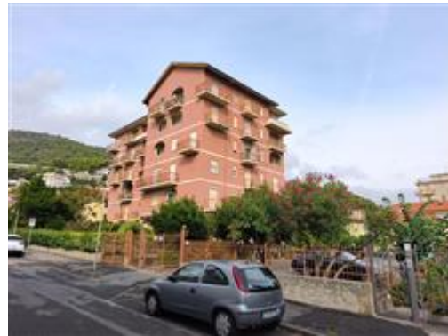
VISTA DEL FABBRICATO DA SUD-EST
