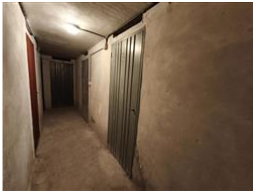
CORRIDOIO E PORTA INGRESSO CANTINA
