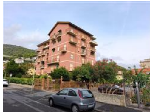
VISTA DEL FABBRICATO DA SUD-EST
