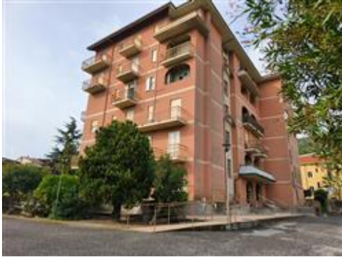
VISTA DEL FABBRICATO DA NORD-EST
