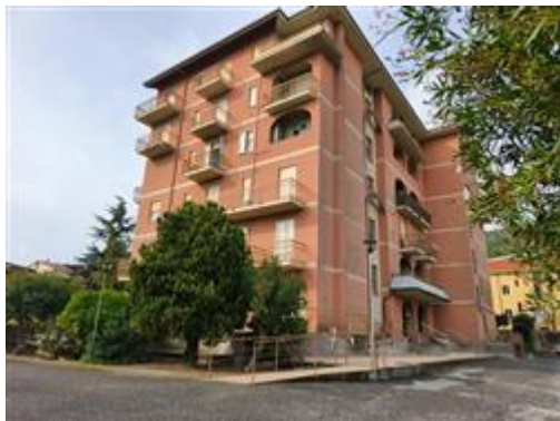
VISTA DEL FABBRICATO DA NORD-EST
