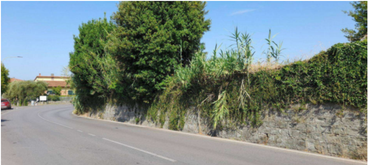
F.11 Via Dante Alighieri - muro di contenimento terreno
