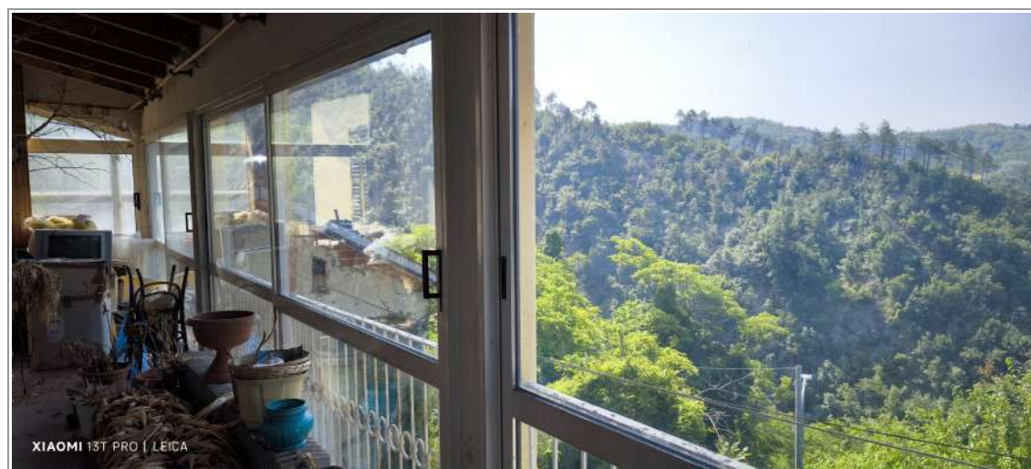
Foto n.24 : veranda al P1
