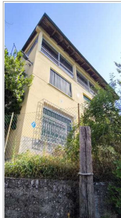
Foto n.3: facciata su lato sud
