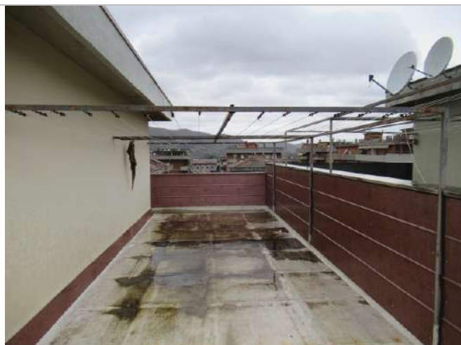
Foto n. 29: Lastrico condominiale piano 5°
