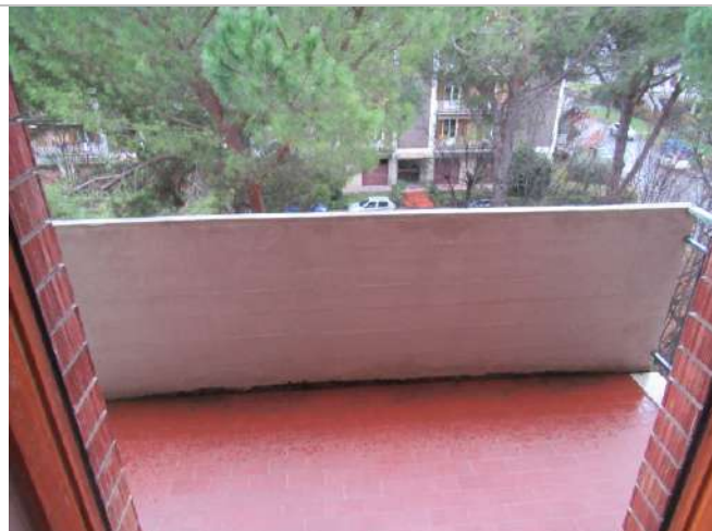
Foto n. 22: Sub. 9 - Balcone aggettante (Est)
