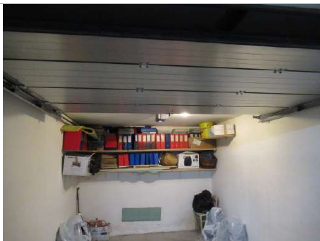
Foto n. 40: Sub. 27 - Garage piano S1
