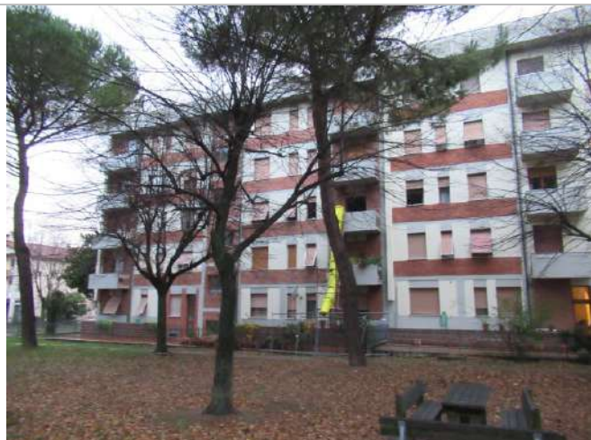
Foto n. 51: Intero edificio / Facciata lato Est
