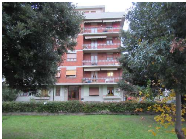
Foto n. 46: Intero edificio / Facciata lato Ovest
