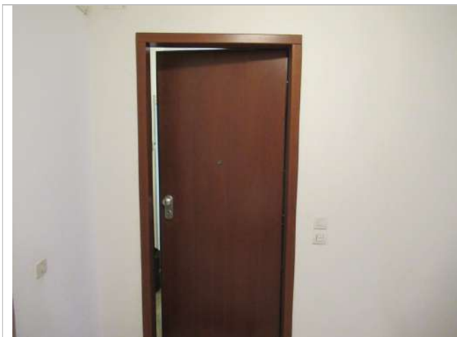
Foto n. 1: Sub. 9- Porta di ingresso al piano 4°
