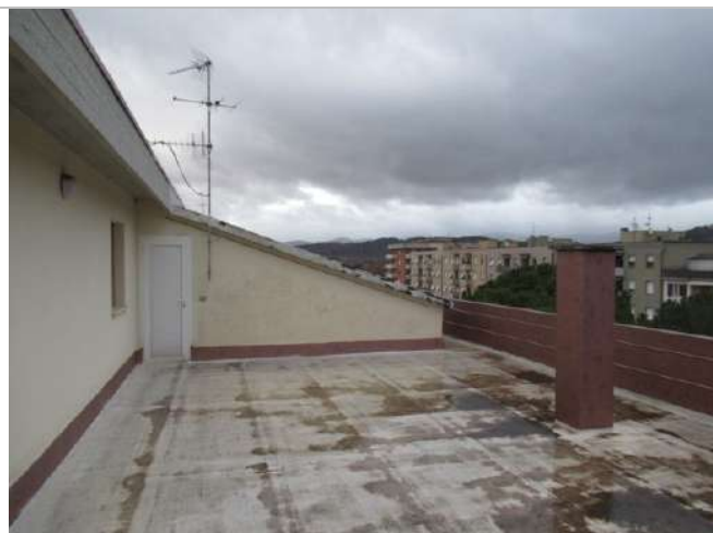
Foto n. 32: Lastrico condominiale piano 5°
