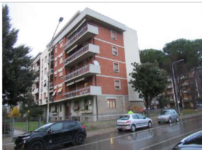
Foto n. 47: Intero edificio / Spigolo Sud-Ovest
