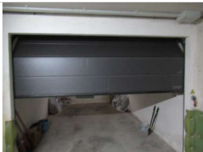
Foto n. 39: Sub. 27 - Garage piano S1
