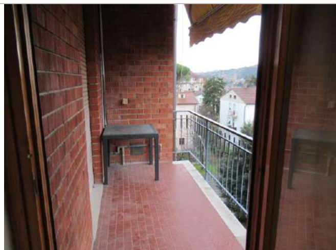
Foto n. 23: Sub. 9 - Balcone chiuso 3 lati (Ovest)
