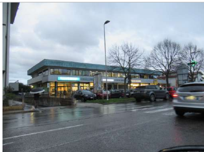
Foto n. 54: Particolare servizi in zona
