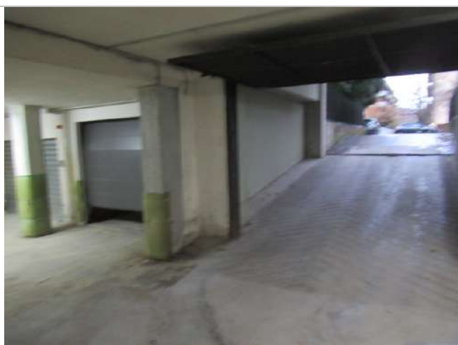
Foto n. 42: Parti comuni / rampa piano S1
