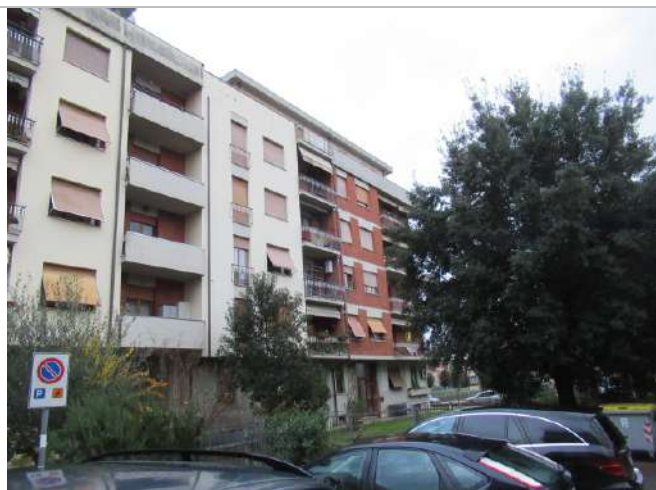
Foto n. 45: Intero edificio / Facciata lato Ovest
