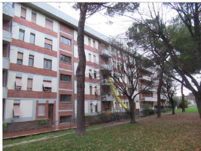
Foto n. 50: Intero edificio / Facciata lato Est
