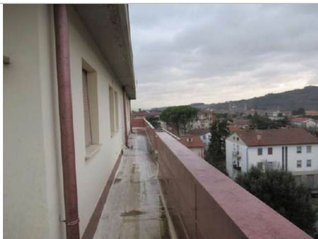
Foto n. 30: Lastrico condominiale piano 5°
