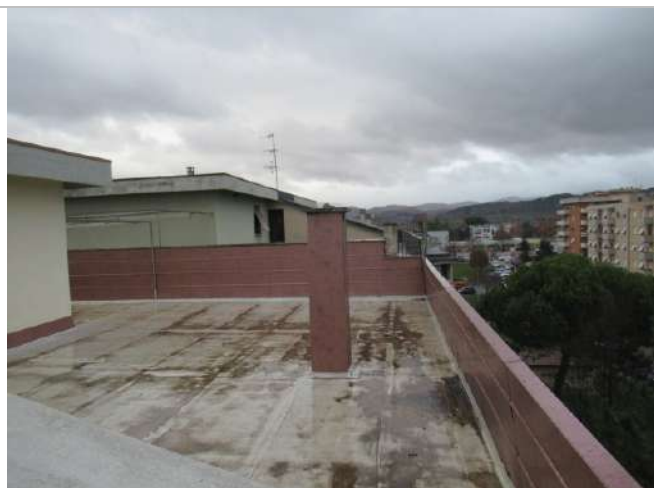
Foto n. 33: Lastrico condominiale piano 5°
