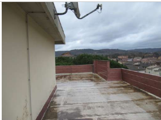
Foto n. 31: Lastrico condominiale piano 5°
