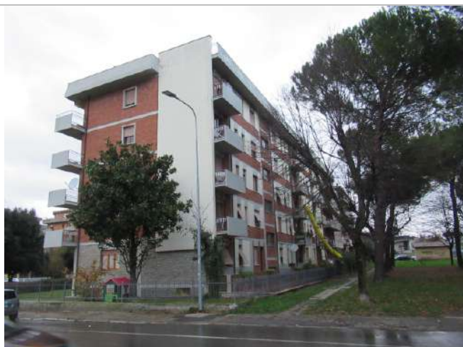
Foto n. 48: Intero edificio / Spigolo Sud-Est)
