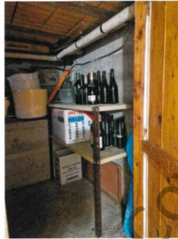
Foto 13: vista della cantina
