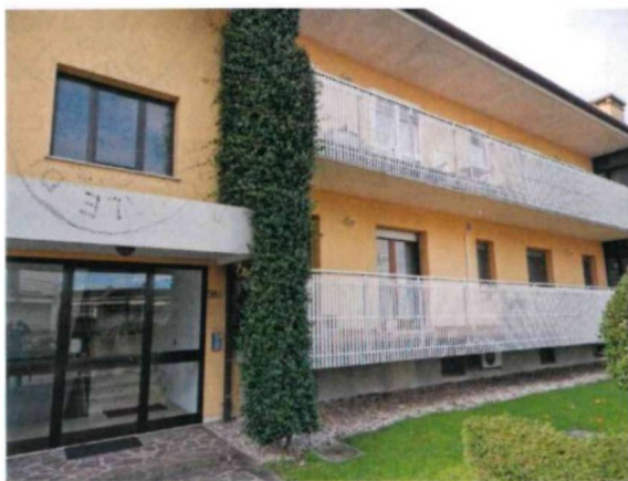
Foto 1: vista fronte strada del fabbricato con l'ingresso al vano scale A
