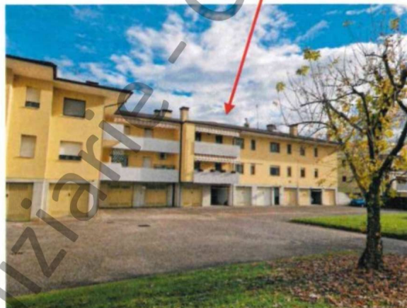
Foto 2: vista del fabbricato dalla corte posteriore. L'appartamento in parola è indicato dalla freccia rossa
