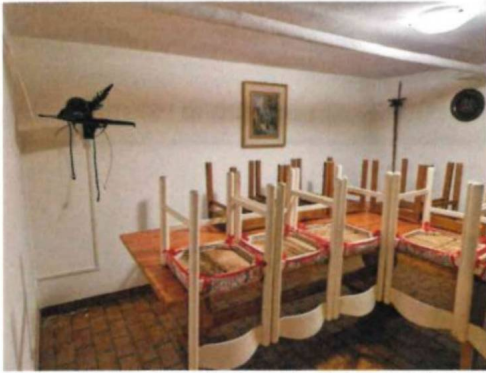
Foto 12: il secondo locale del seminterrato
