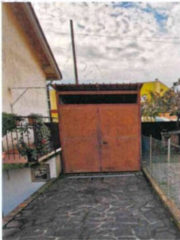
Foto 14: vista esterna dell'autorimessa
