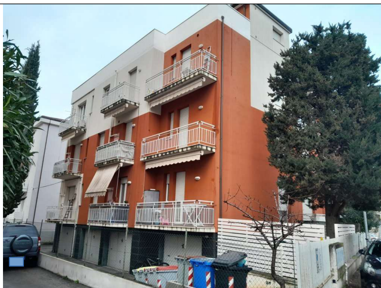
Foto 1.03. – Fabbricato condominiale: fronte laterale opposto a via Montanari
