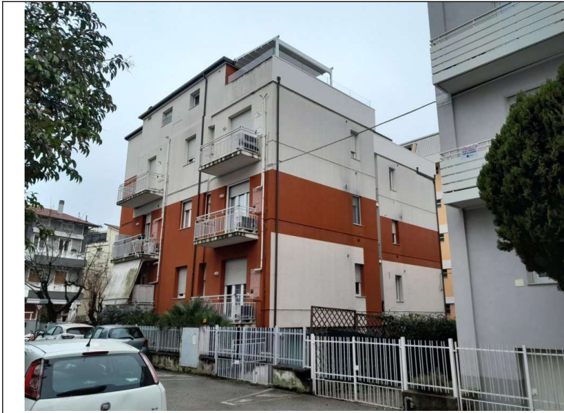
Foto 1.04. – Fabbricato condominiale: fronte sul retro e laterale su via C. Montanari
