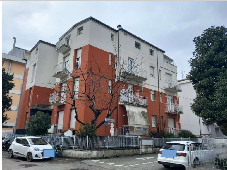
Foto 1.01. – Fabbricato condominiale: fronti principale (su via Ciro Menotti) e laterale su via C. Montanari
