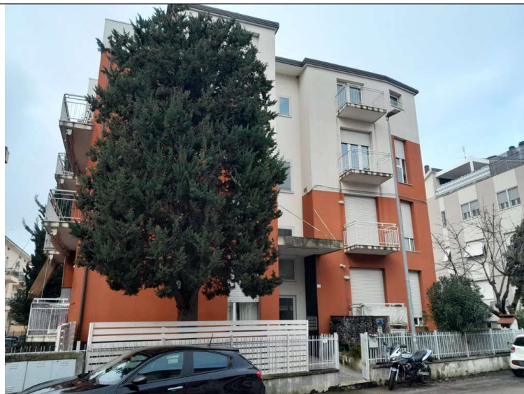
Foto 1.02. – Fabbricato condominiale: fronte laterale su via C. Montanari
