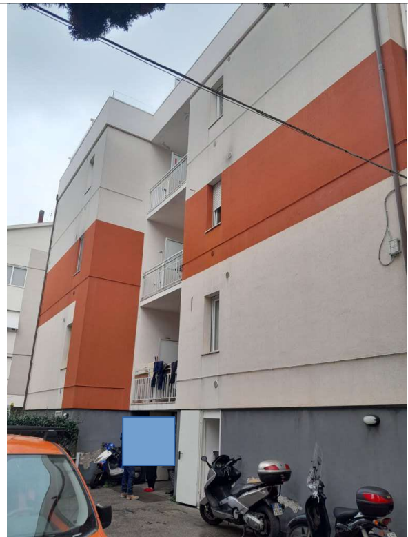
Foto 1.06. – Fabbricato condominiale: fronte sul retro
