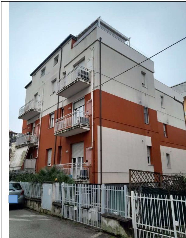
Foto 1.05. – Fabbricato condominiale: fronte sul retro e laterale su via C. Montanari
