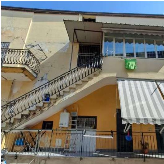
VISTA DEL FABBRICATO
