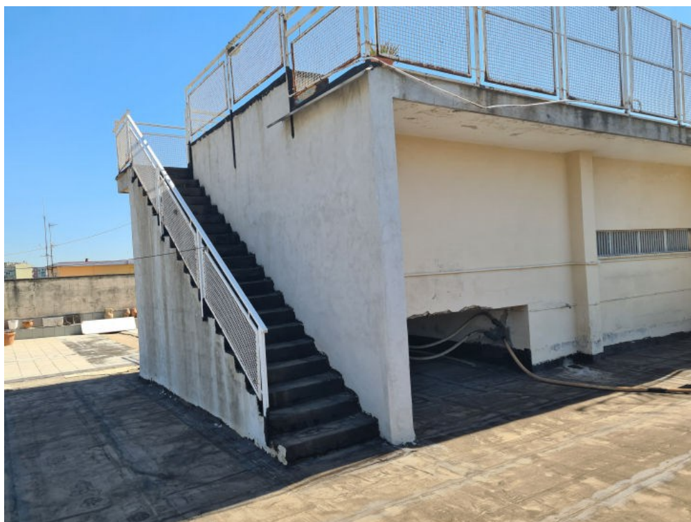
Foto 34- la scala e la parete laterale della piscina
