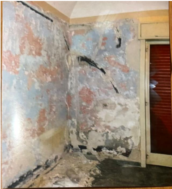
Foto n.15 – Parete del salotto rivestita a causa di infiltrazioni esterne
