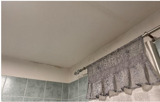
Foto n. 11-12 – Presenza di infiltrazioni e condensa nella parete del WC bagno
