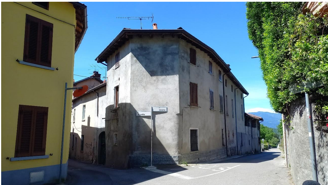
Vista del fabbricato dall'esterno
