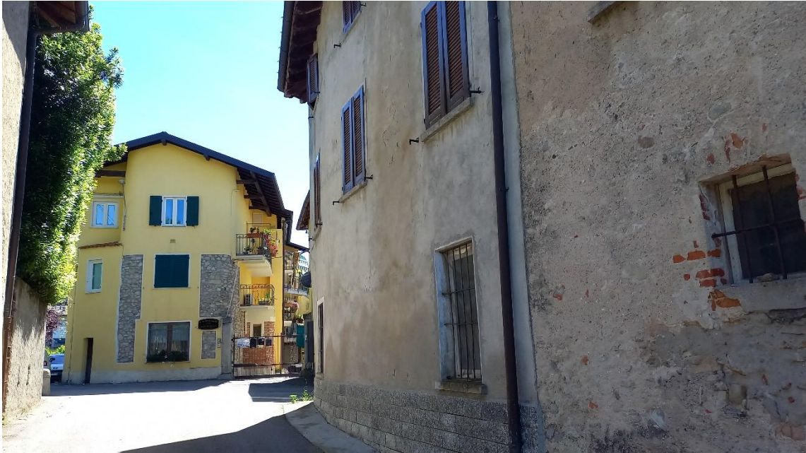
Vista del fabbricato dall'esterno
