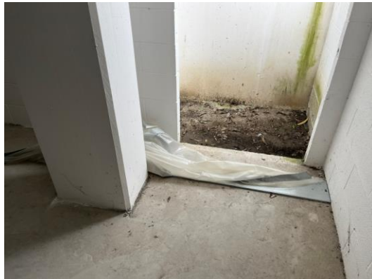
a) Assenza serramenti a chiusura dell'intercapedine comune
