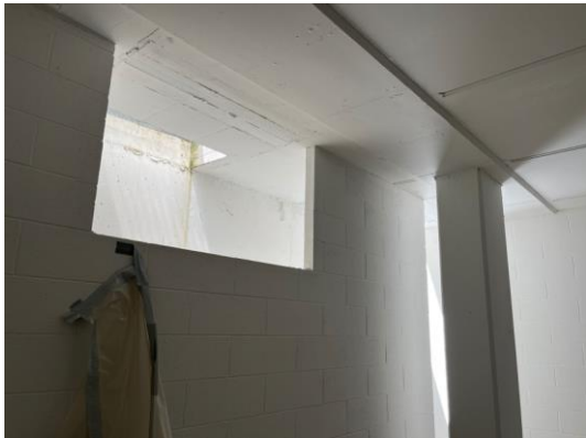
a) Assenza serramenti a chiusura dell'intercapedine comune
