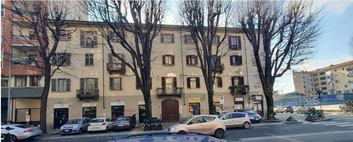
Fig. – stabile – facciata su strada con portone di ingresso
