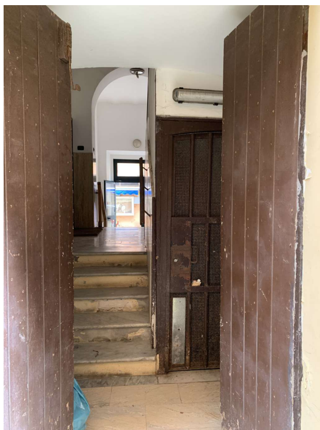
Foto n. 4 – Vista atrio dal cortile condominiale
