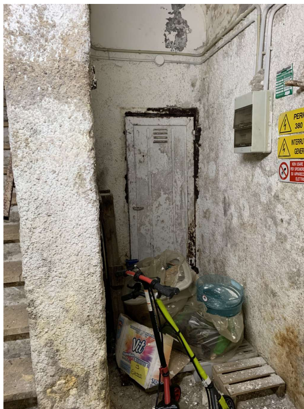
Foto n. 13 – Vista accesso sottoscala
