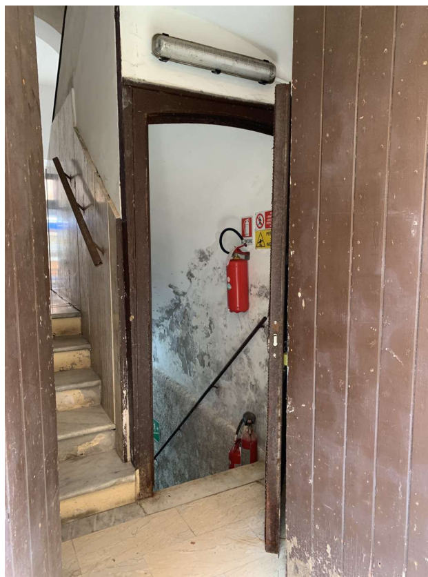
Foto n. 5 – Vista porta d'accesso al magazzino
