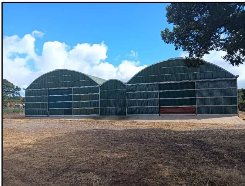
Foto 1 - Vista esterna dell'immobile
