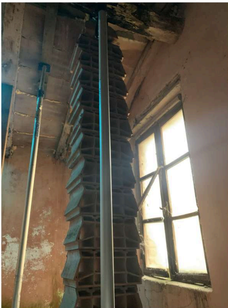
5 - Locale sottotetto sub. 503
