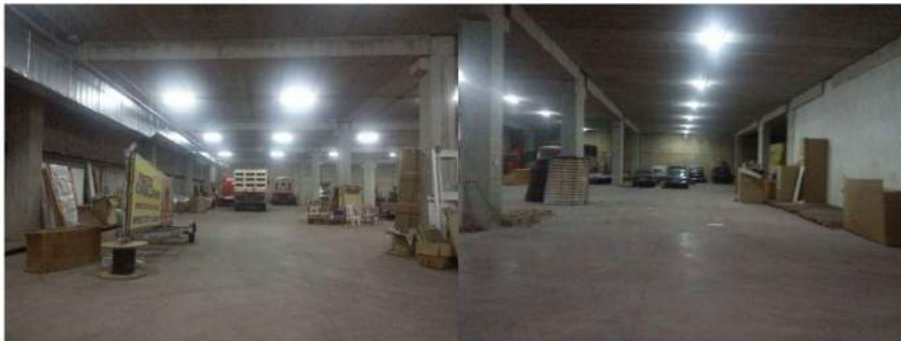
Figura 12: Vista del locale deposito.
