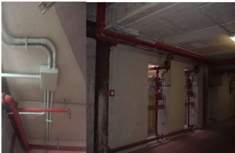
Figura 10: Impianto Sprinkler.
