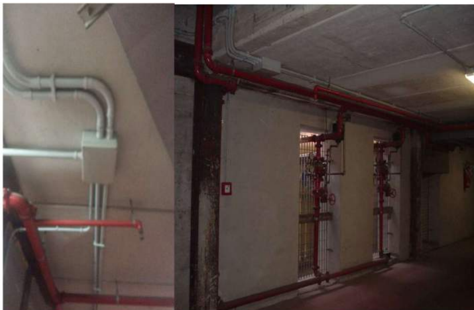
Figura 10: Impianto Sprinkler.
