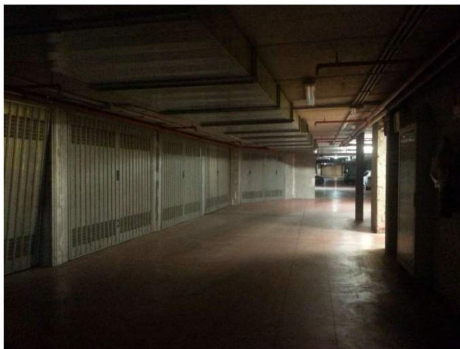
Figura 9: Canalizzazioni dell'impianto di ventilazione forzata.
