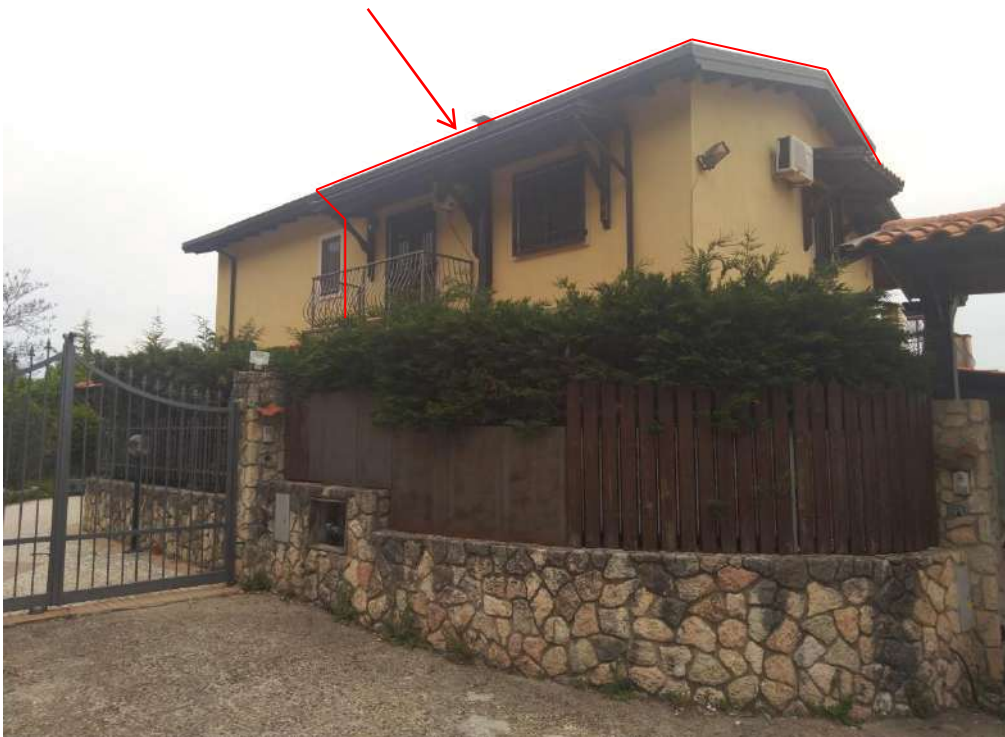
FOTO 2 – Vista SUD – OVEST
