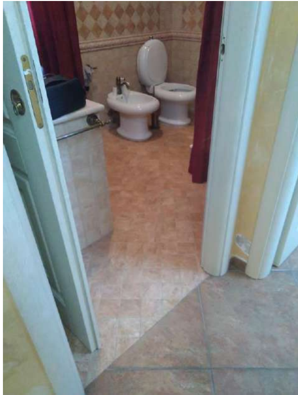
FOTO 12 – Bagno al piano terra
