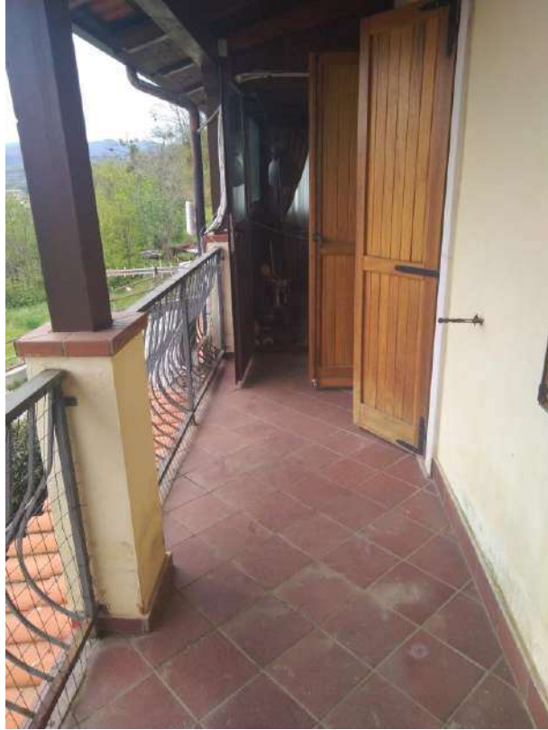
FOTO 15 – Balcone al piano terra
