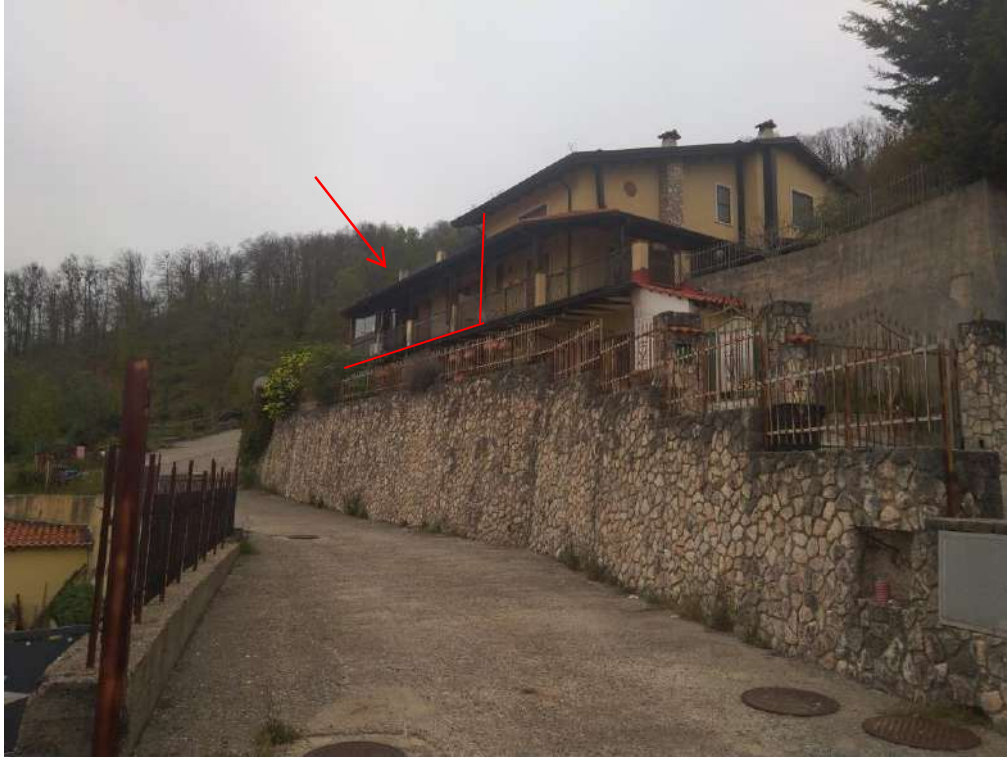
FOTO 3 – Vista NORD – EST
