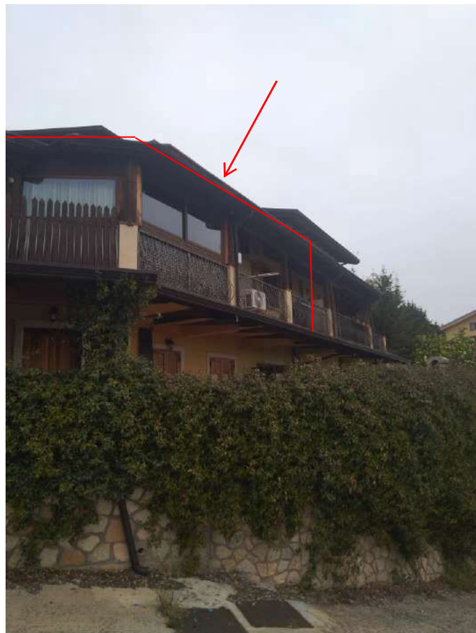
FOTO 4 – Vista SUD – EST
