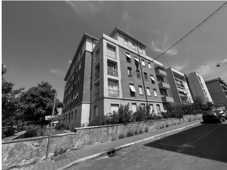
Foto 1 – vista generale dell'edificio da via Turati
