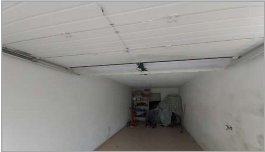
Foto " 5 " – Vista dei Box Auto identificati da porzioni dei Sub 5 e 6
