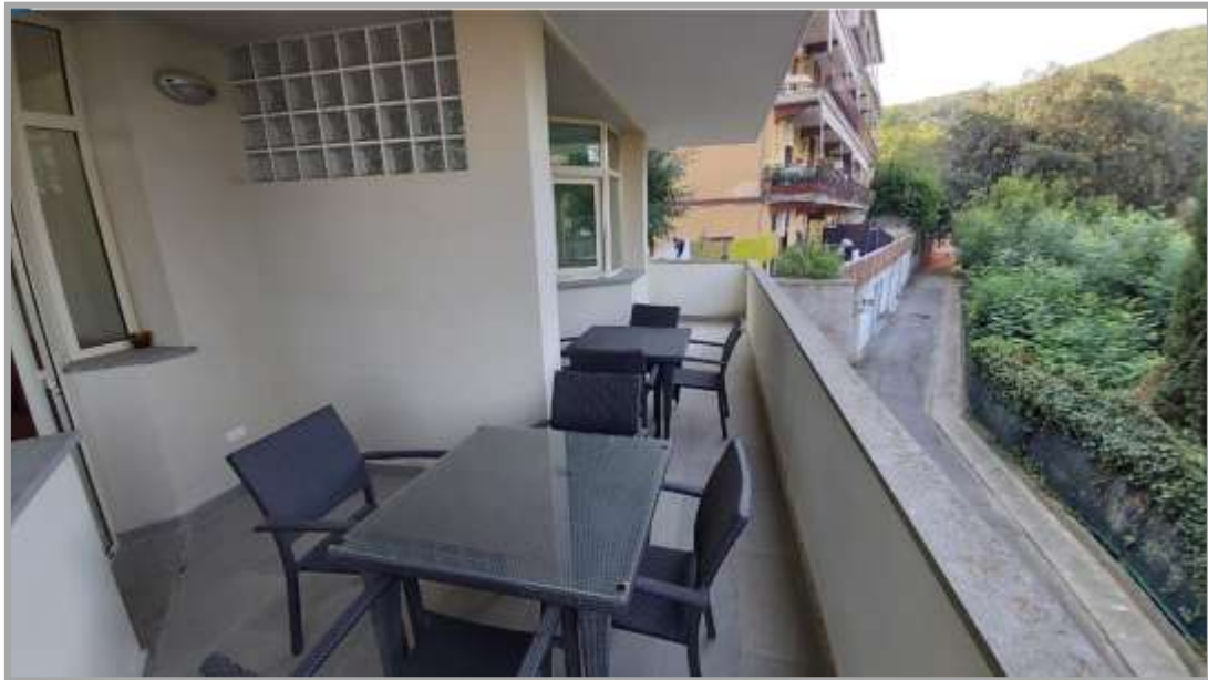
Foto " 13 " – Vista delle terrazze del sub 5 e del sub 6
