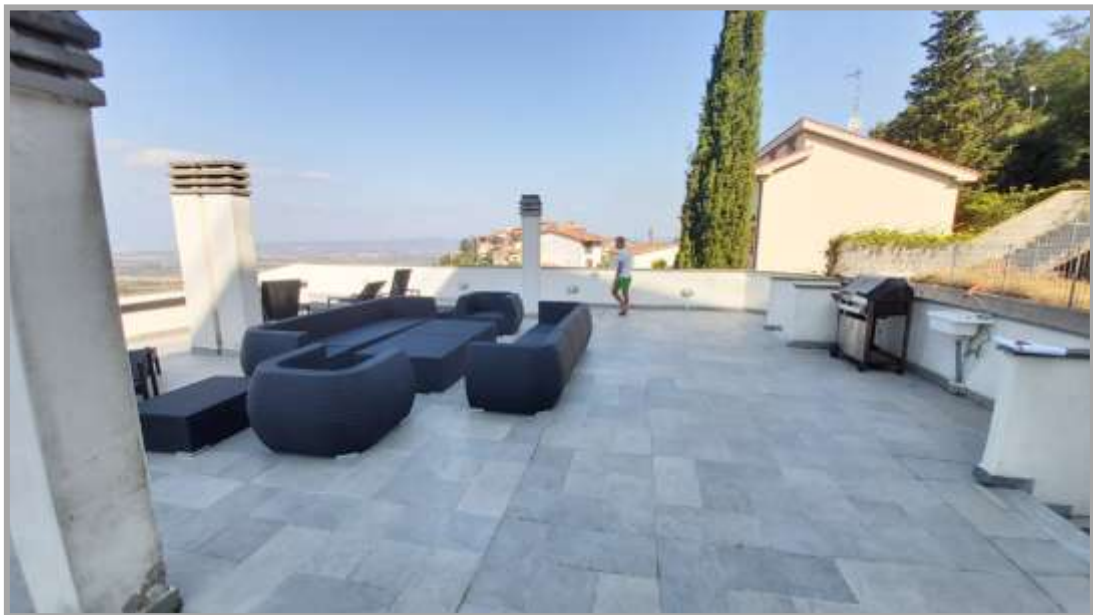
Foto “ 44 ” – Vista del lastrico solare
