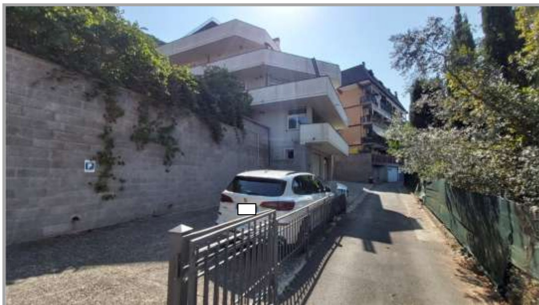
Foto “ 1 ” – Vista del fabbricato dalla Via Piave
