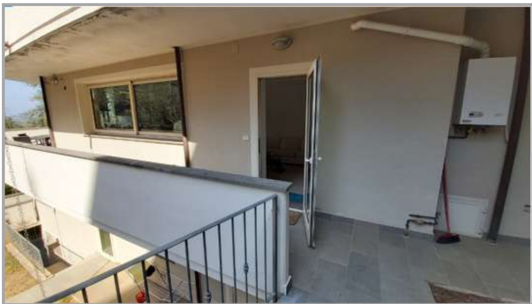
Foto " 34 " – Vista del portone di accesso al sub 8
