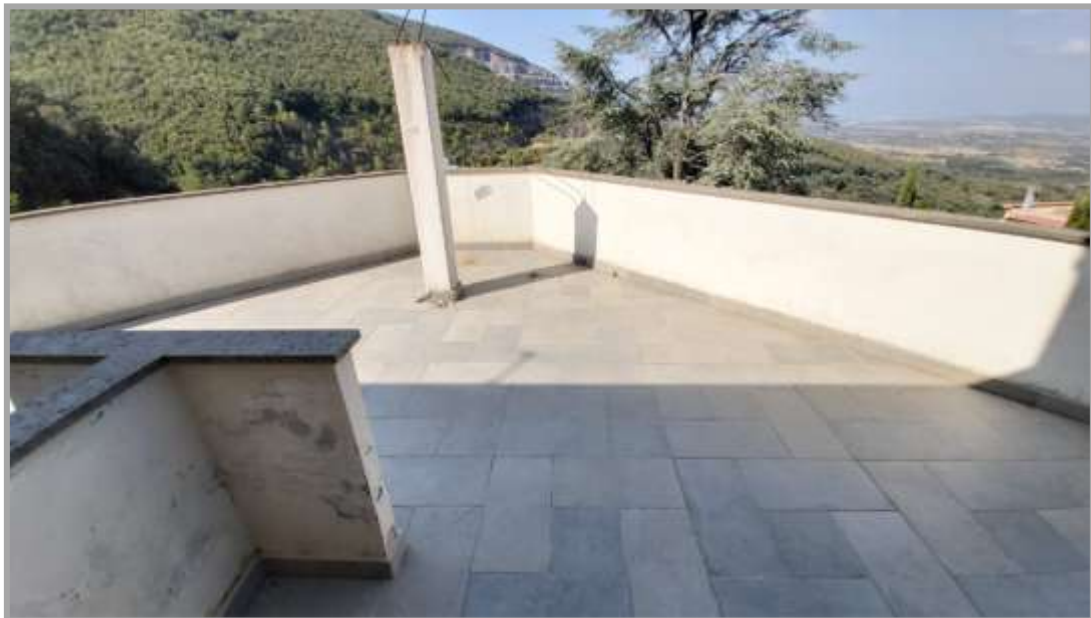
Foto “ 32 ” – Vista della terrazza al piano terzo del sub 7 e del sub 8
