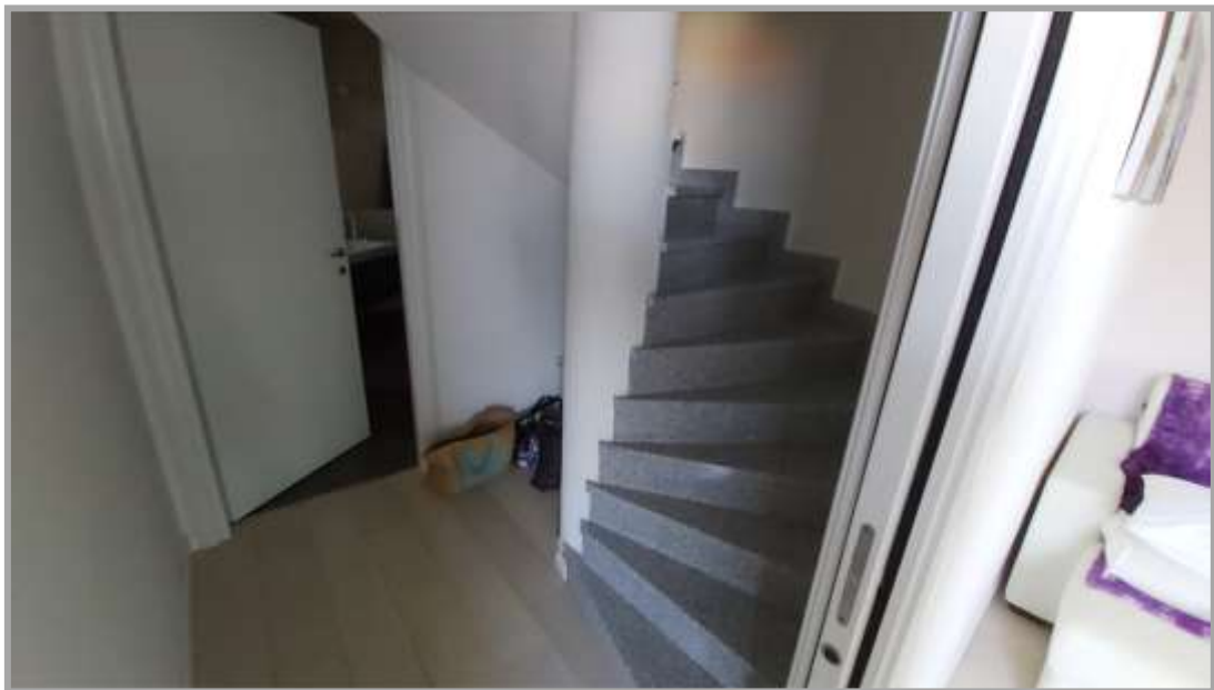
Foto " 24 " – Vista del disimpegno e della scala di accesso al piano terzo del sub 7
