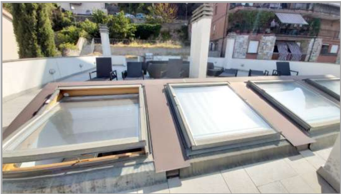
Foto “ 46 ” – Vista del lastrico solare
