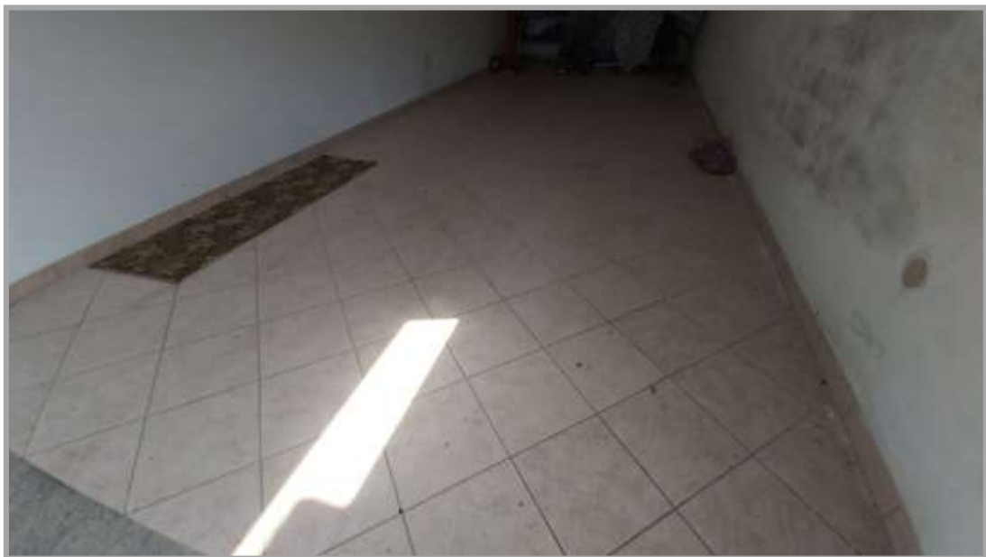
Foto " 6 " – Vista dei Box Auto identificati da porzioni dei Sub 5 e 6
