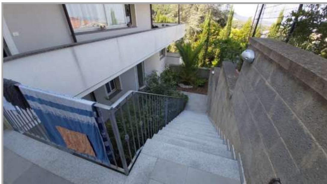
Foto “ 20 ” – Vista della scala esterna di accesso ai sub 5 e 7 e dell’ingresso del sub 7
