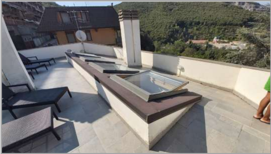
Foto “ 45 ” – Vista del lastrico solare
