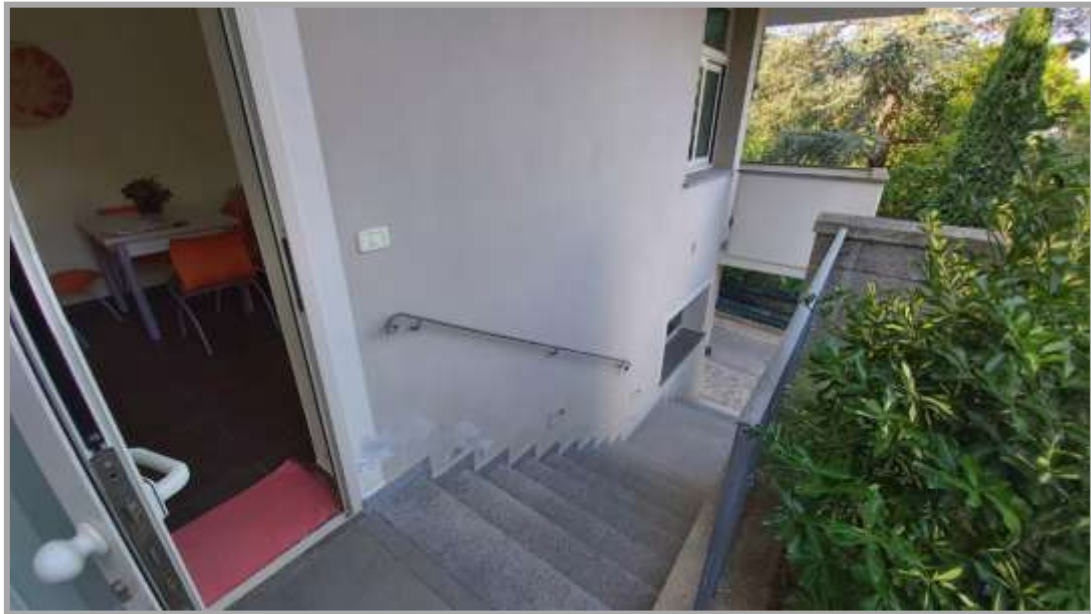
Foto " 7 " – Vista della scala esterna di accesso ai sub 5 e 7 e del portone di ingresso del sub 5
