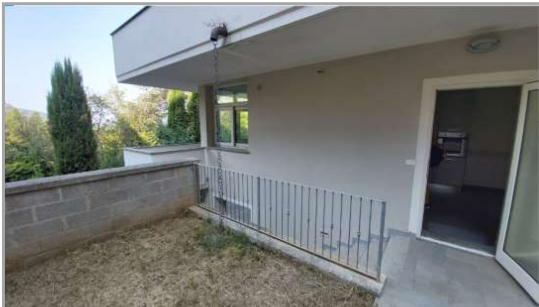
Foto " 14 " – Vista della scala esterna di accesso ai sub 6 e 8 e del portone di ingresso del sub 6
