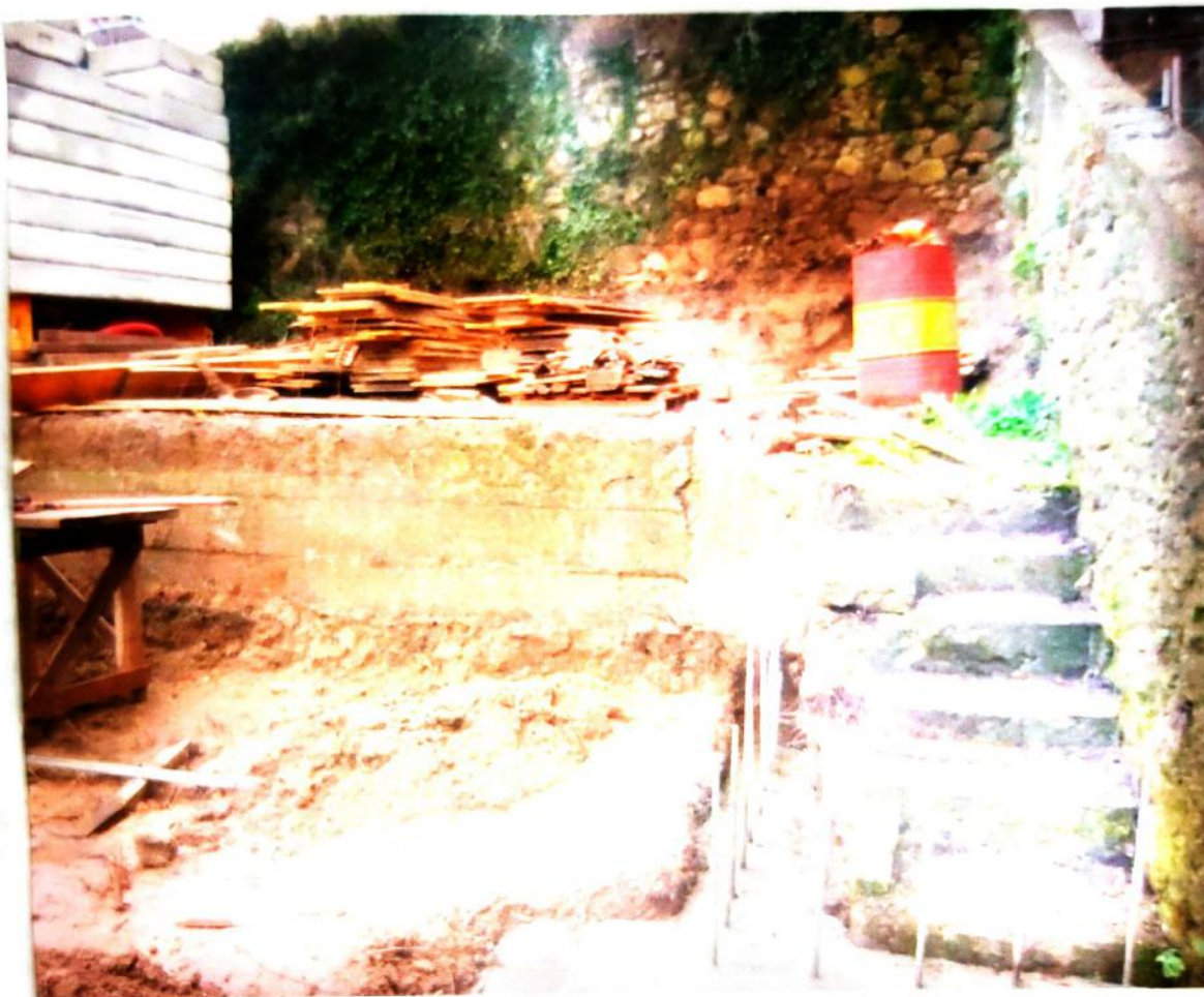
ATIVE ALLA SCALA E MURO INTERNI AL GIARDINO
