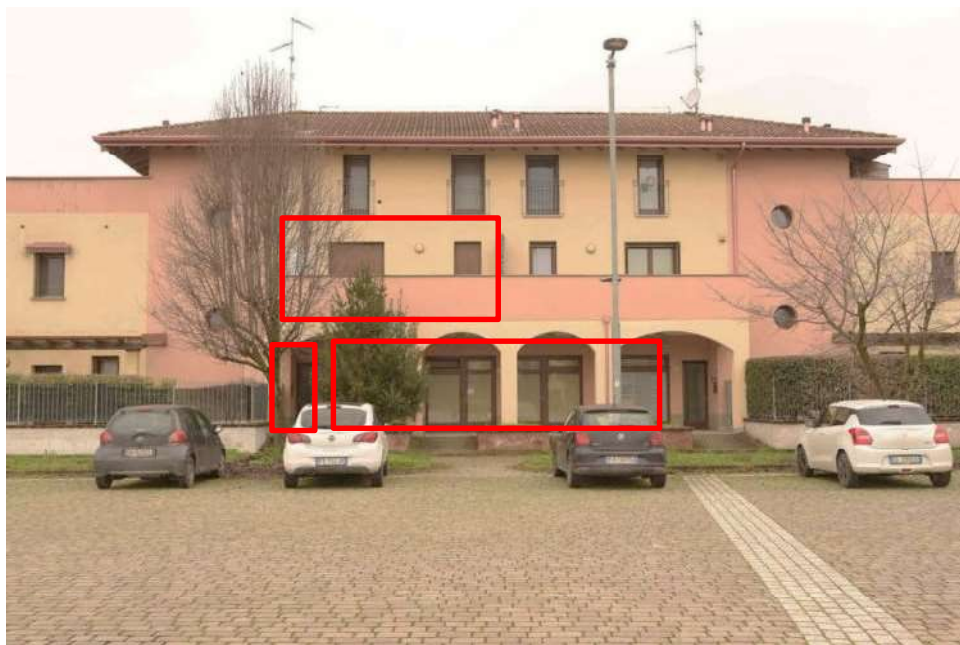
Prospetto principale su Piazza Tommaso Caprioli
