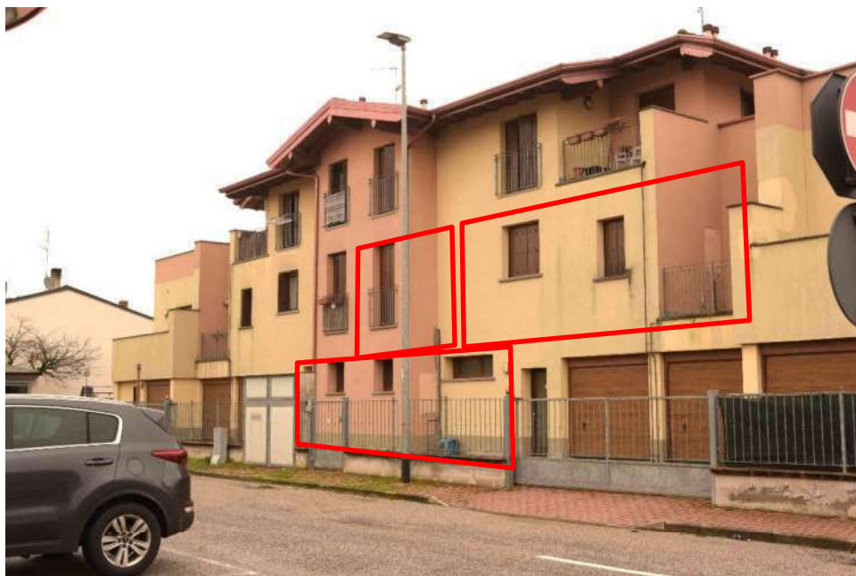
Prospetto su Via degli Scariolanti
