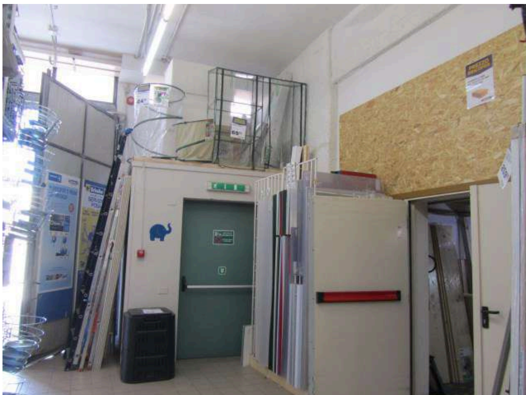
Foto n.37: Disimpegno aerato da locale di vendita alla scala d'accesso al piano soppalco
