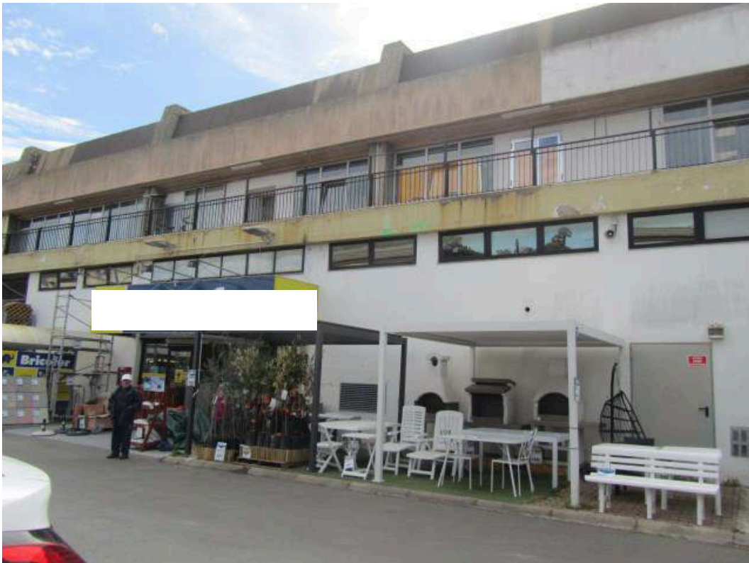
Foto n.7: Prospetto e ingresso al locale di vendita
