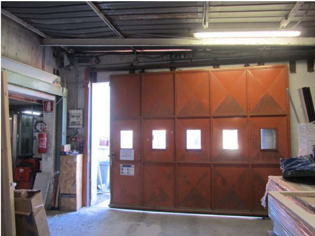
Foto n.51: Portellone di uscita dal deposito scorte all'area cortilizia esterna
