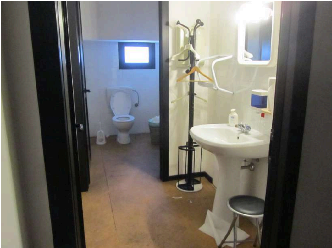
Foto n.74: Antibagno del primo corridoio
