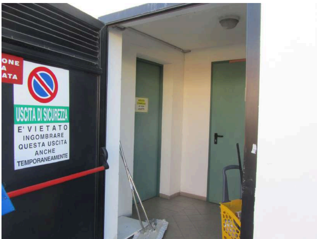
Foto n.60: Filtro aerato che separa il vano scala dal locale di vendita
