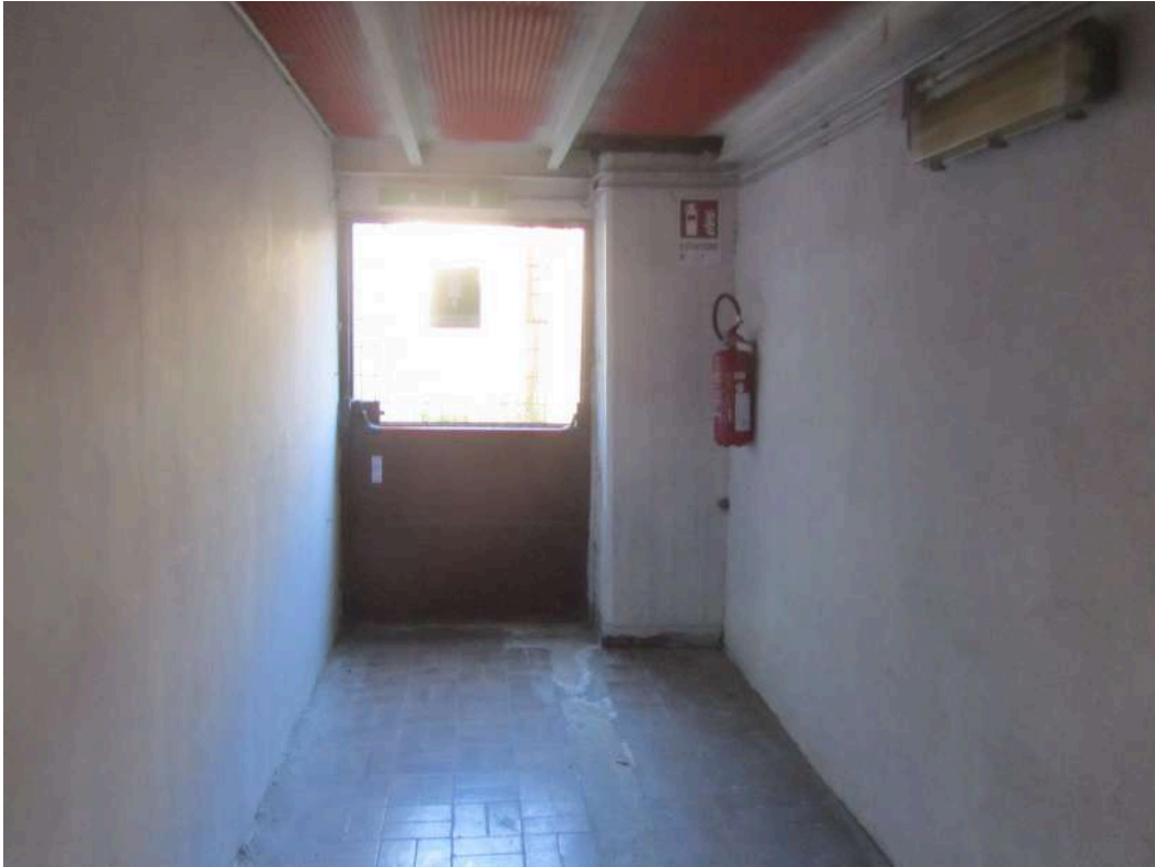
Foto n.91: Disimpegno aerato verso la via di fuga esterna
