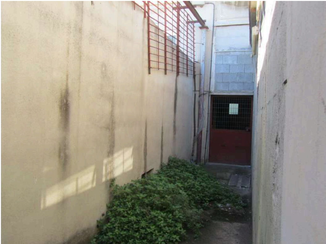
Foto n.92: Via di fuga esterna dal disimpegno aerato
