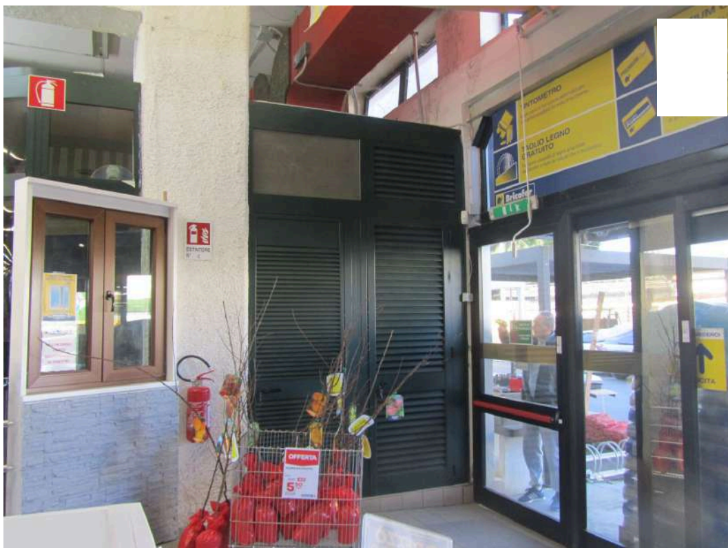
Foto n.17: Locale tecnico a fianco all'ingresso al locale di vendita
