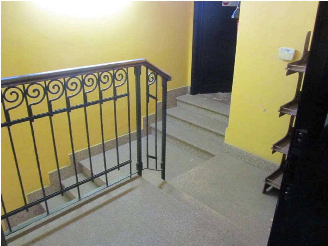
Foto n.62: Vano scala che conduce al piano soppalco ed accesso al locale tecnico monitor
