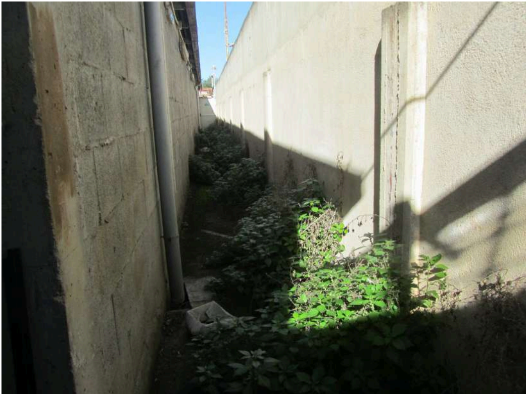
Foto n.58: Via di fuga esterna verso l'area cortilizia
