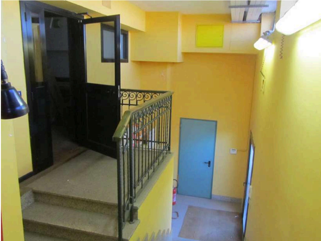
Foto n.61: Vano scala che conduce al piano soppalco
