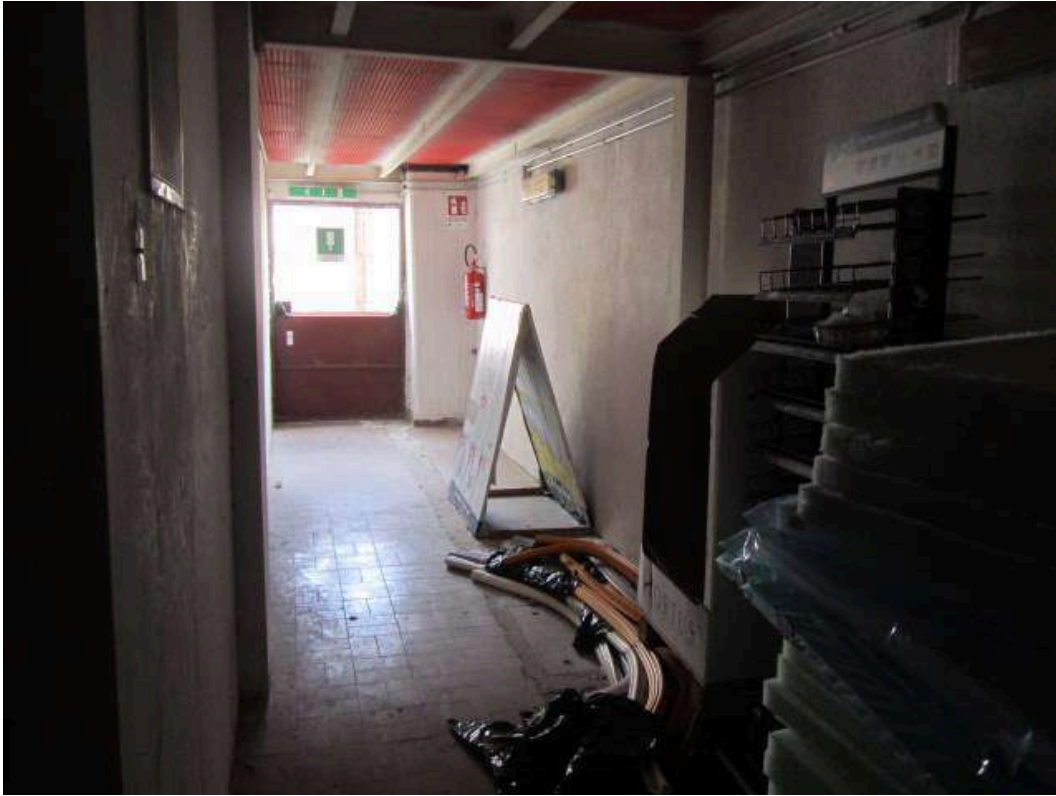
Foto n.47: Disimpegno aerato verso via di fuga esterna
