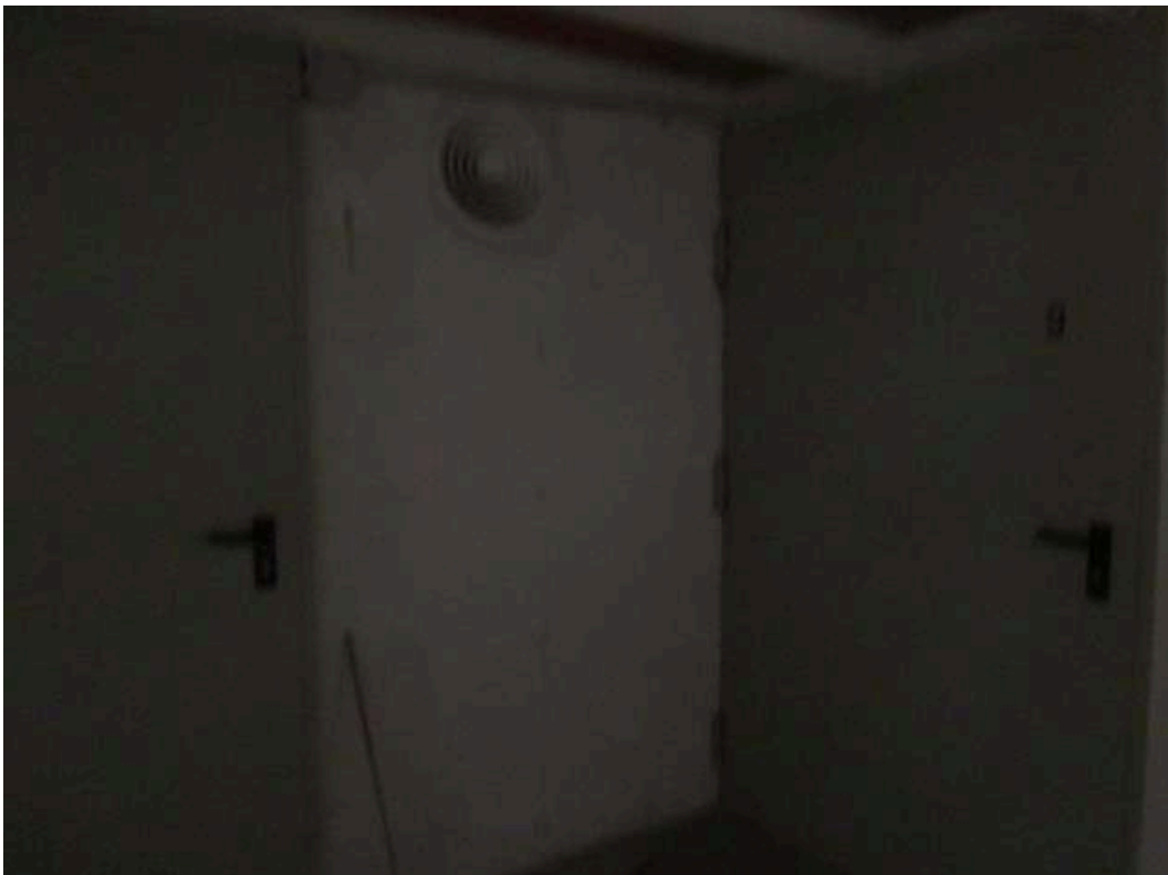
Foto n.46: Uscite di sicurezza dal magazzino materiali ferrosi e dal locale di vendita al disimpegno aerato verso via di fuga esterna
