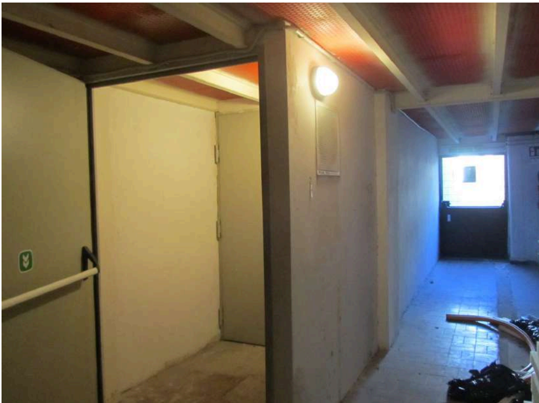
Foto n.90: Disimpegno della scala per uscita secondaria dalla sala riunioni
