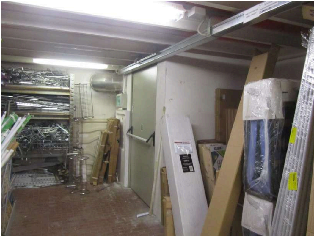
Foto n.45: Disimpegno dal magazzino materiali ferrosi al disimpegno aerato verso via di fuga esterna
