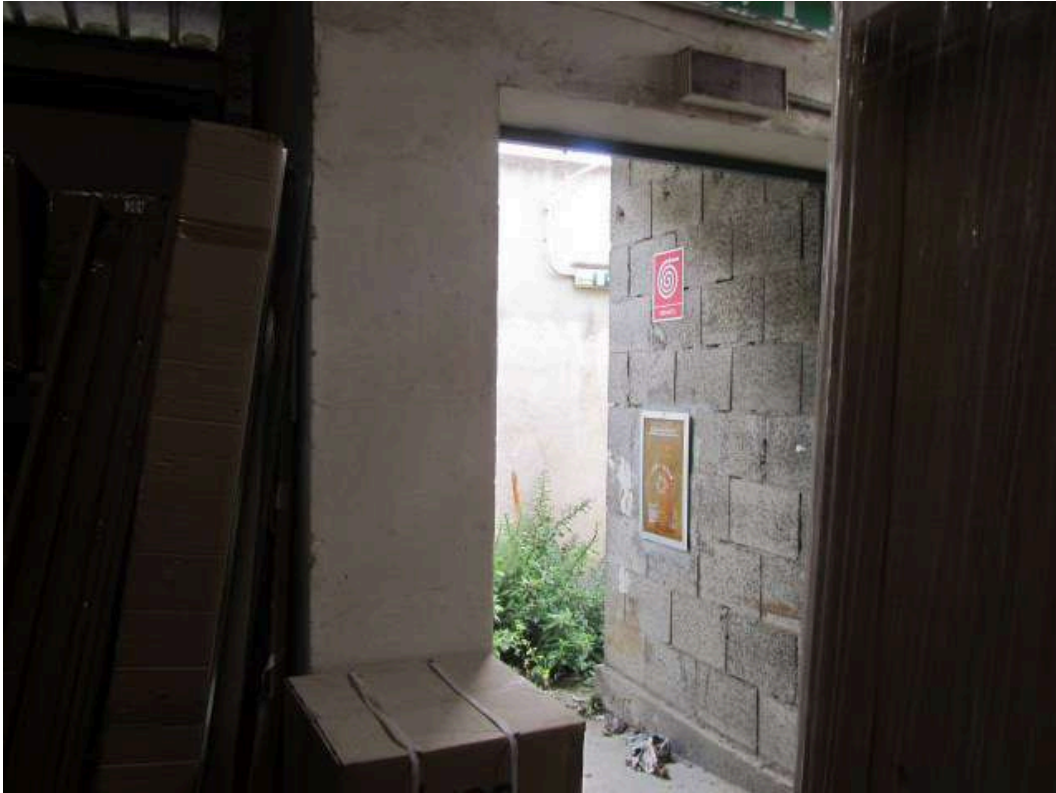
Foto n.57: Uscita di sicurezza dal deposito scorte alla via di fuga esterna
