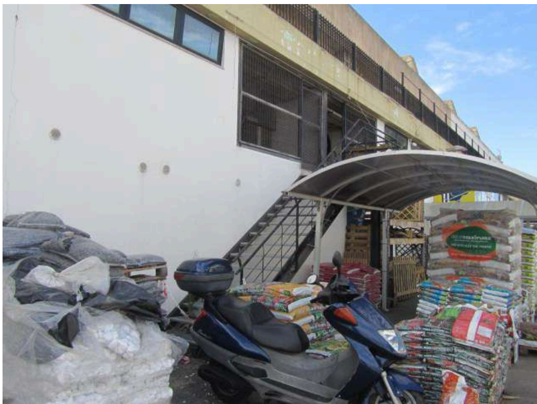
Foto n.9: Prospetto e scala esterna ai vani tecnici a quota +2,90m
