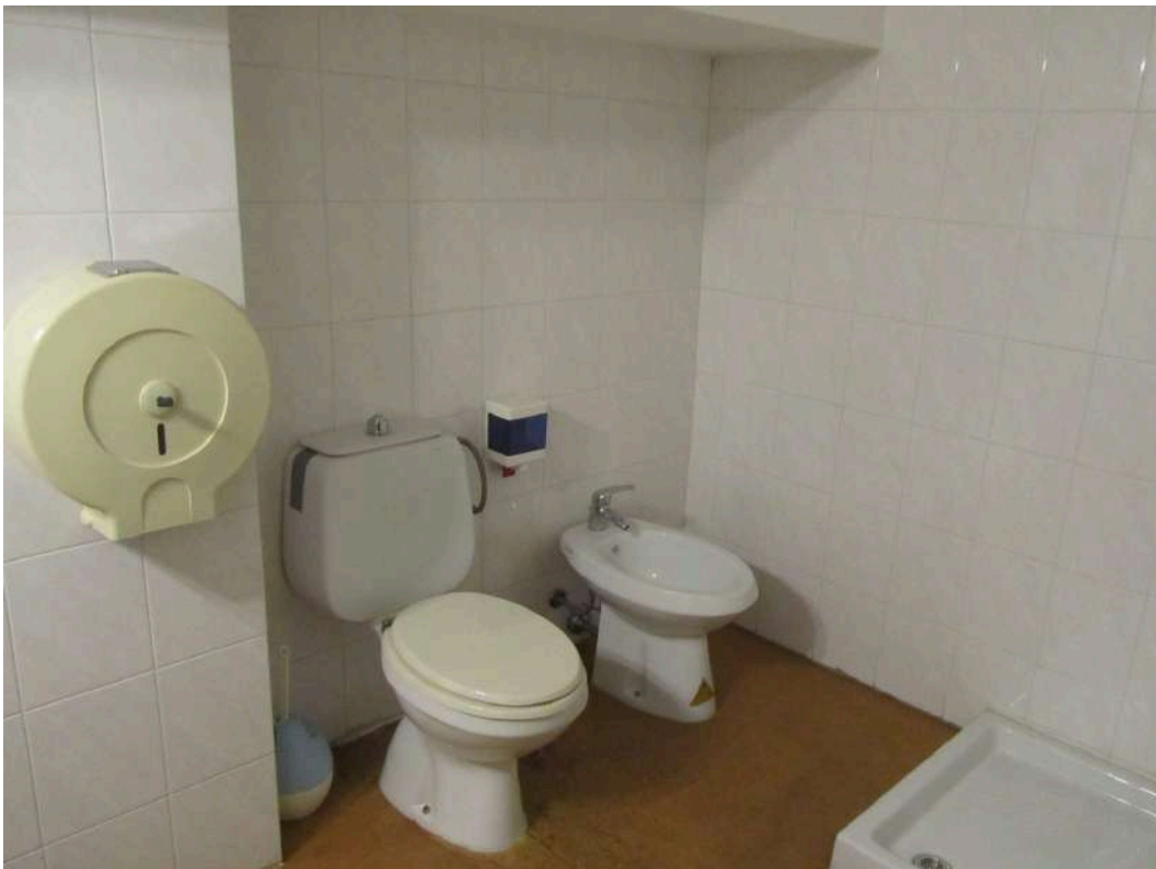
Foto n.84: Bagno del sesto ufficio
