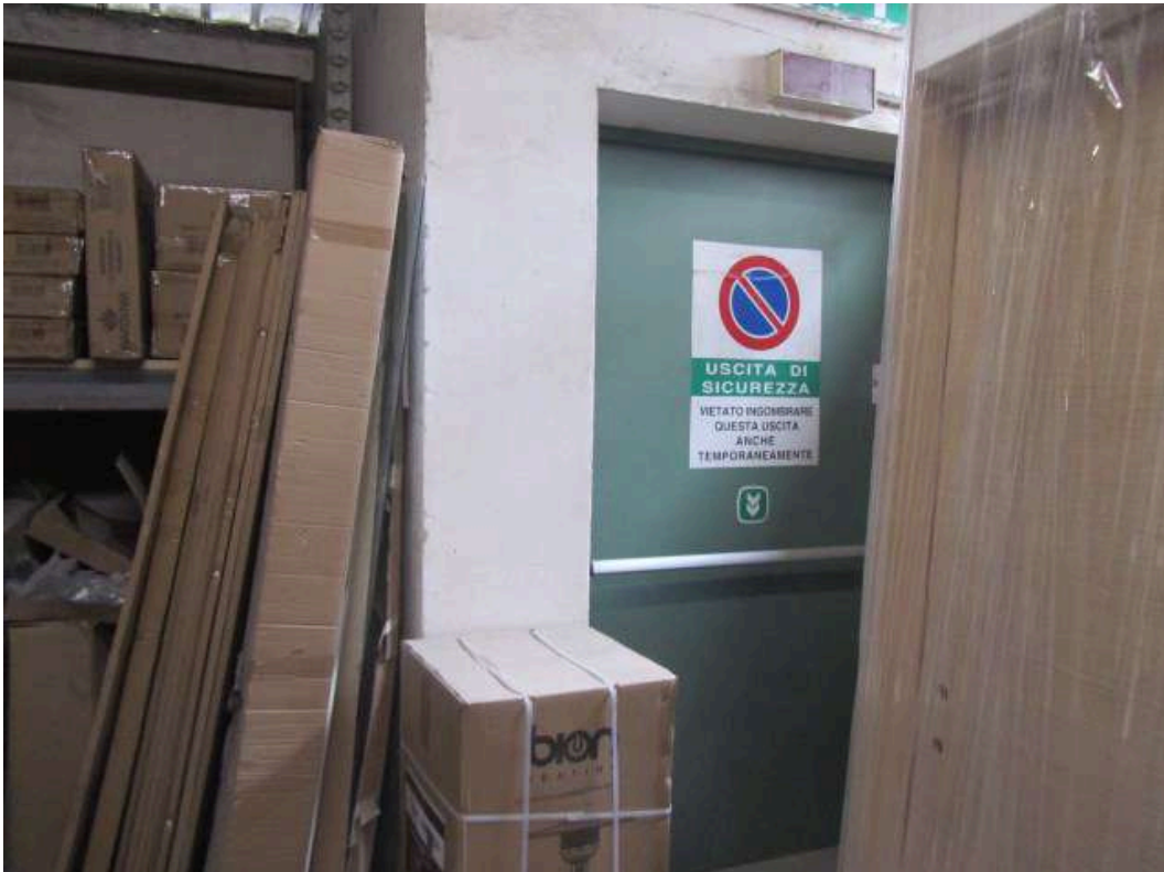
Foto n.56: Uscita di sicurezza dal deposito scorte alla via di fuga esterna
