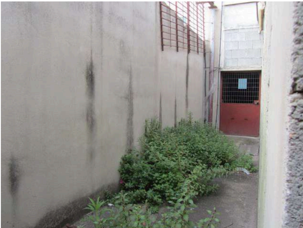
Foto n.48: Uscita dal disimpegno aerato verso via di fuga esterna
