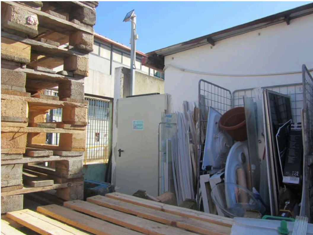
Foto n.15: Prospetto e uscita di sicurezza dalla via di fuga esterna
