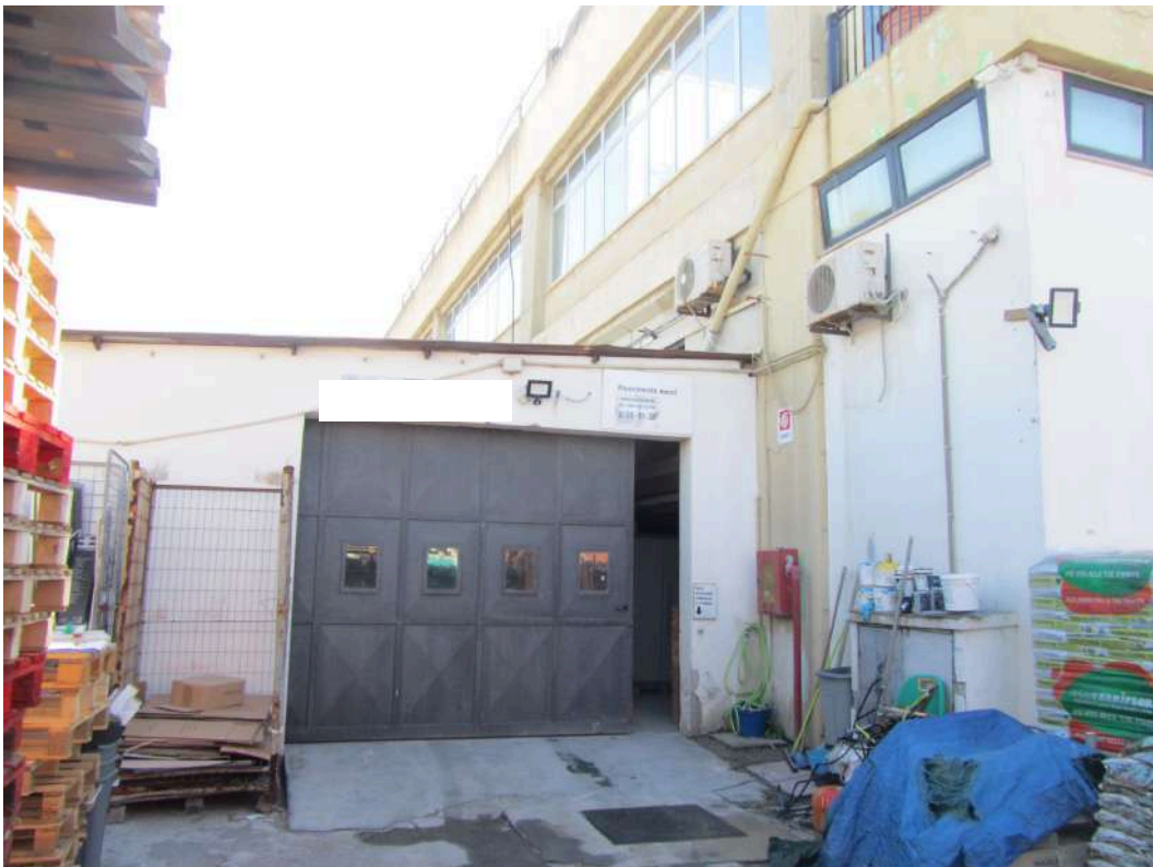
Foto n.14: Prospetto e ingresso al deposito scorte
