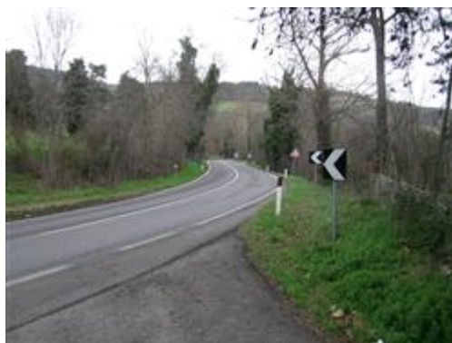
Innesto dalla SP 3 al vialetto d'ingresso
