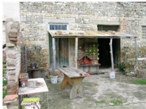
Tettoia da rimuovere
