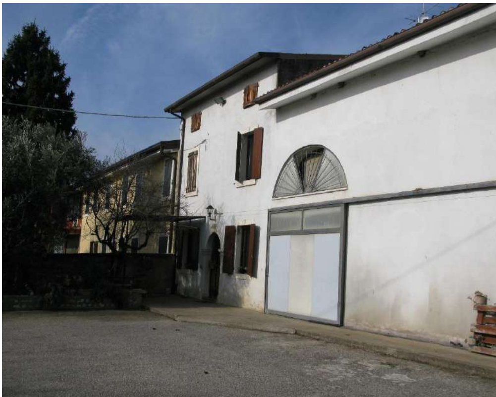
Foto n. 1: Abitazione fronte sud
