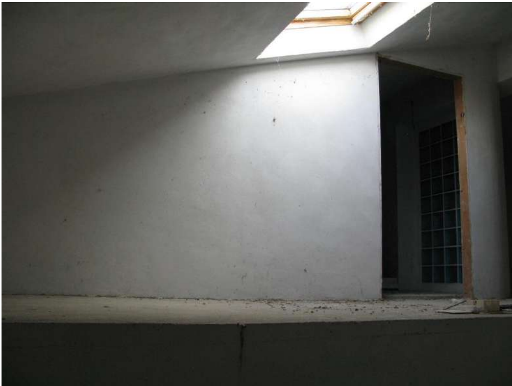
Foto n. 34: Piano secondo - soffitta
