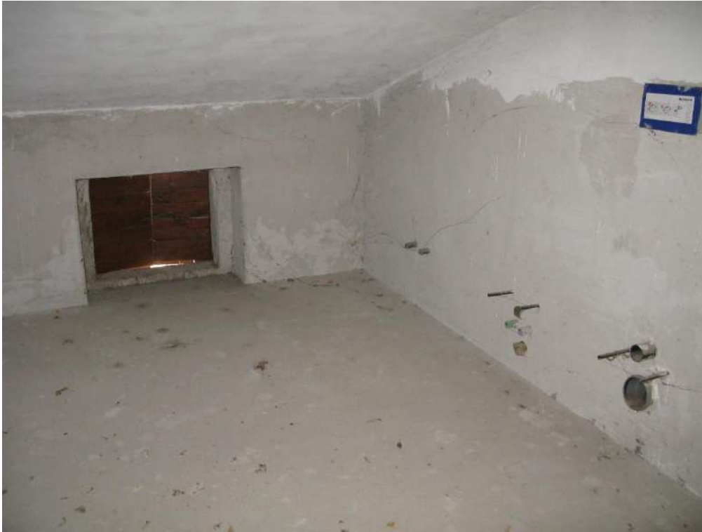
Foto n. 37: Piano secondo - soffitta
