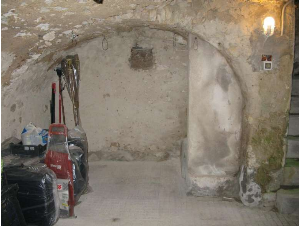
Foto n. 3: Piano primo sottostrada
