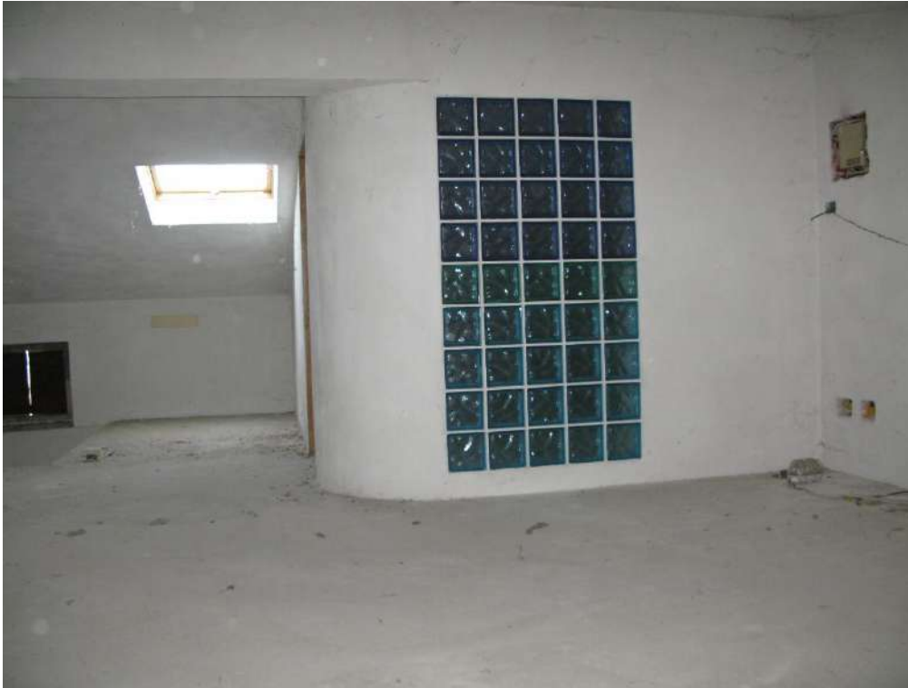
Foto n. 35: Piano secondo - soffitta
