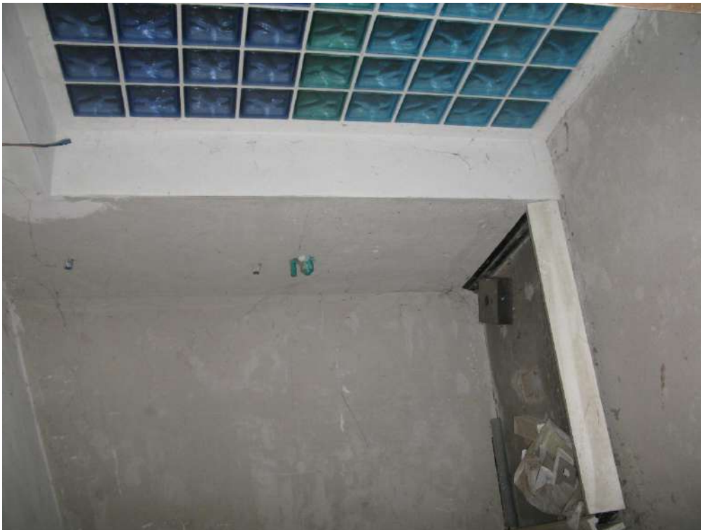
Foto n. 38: Piano secondo - soffitta
