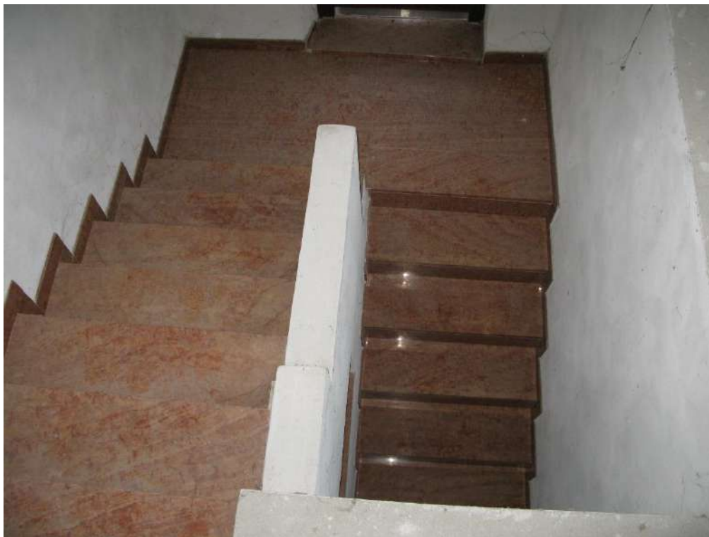
Foto n. 31: Piano secondo - soffitta
