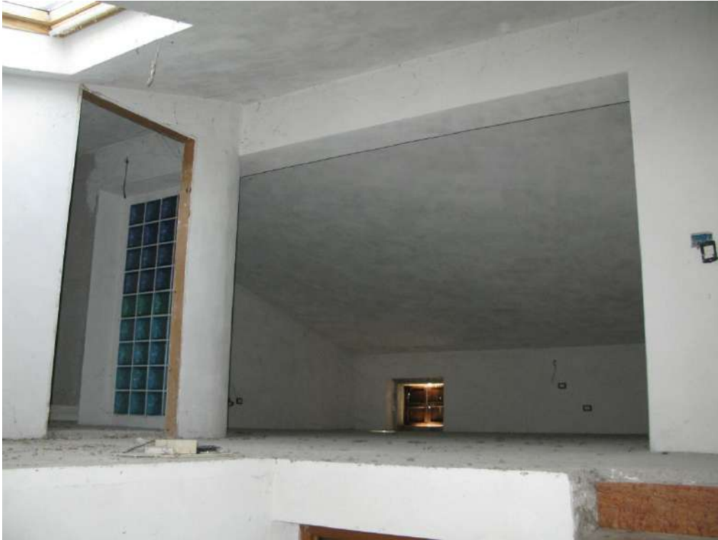
Foto n. 33: Piano secondo - soffitta
