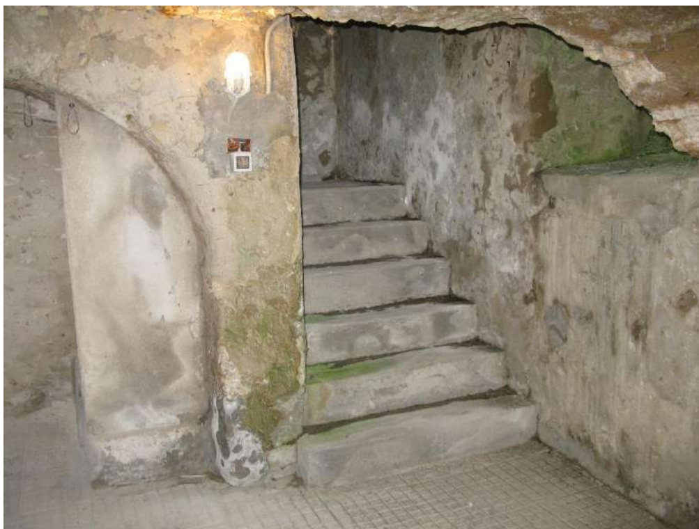
Foto n. 5: Piano primo sottostrada
