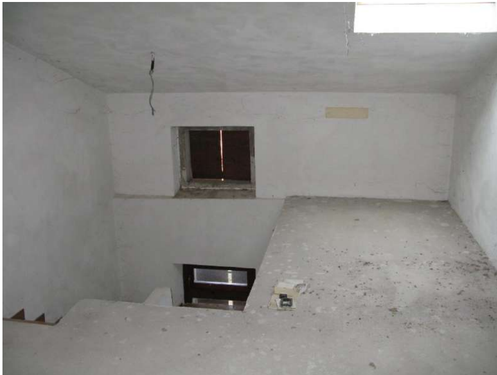
Foto n. 32: Piano secondo - soffitta
