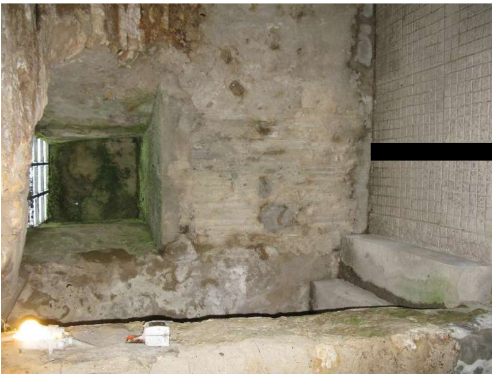
Foto n. 2: Piano primo sottostrada
