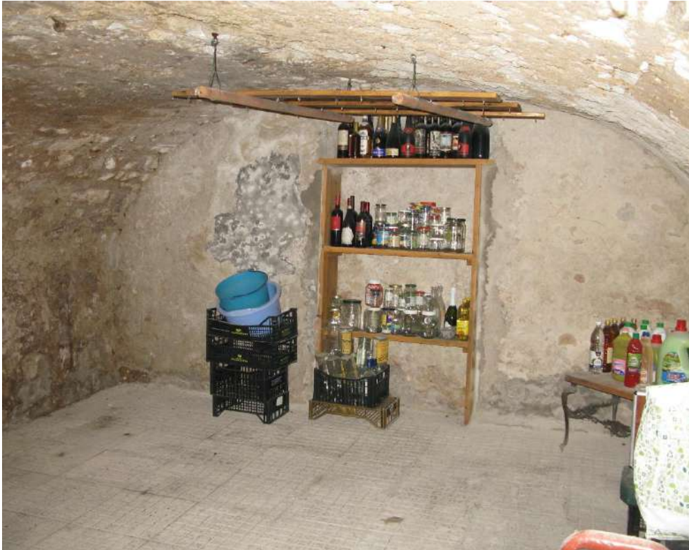
Foto n. 1: Piano primo sottostrada
