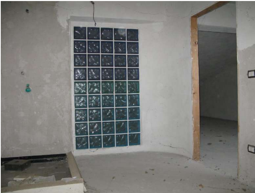
Foto n. 36: Piano secondo - soffitta
