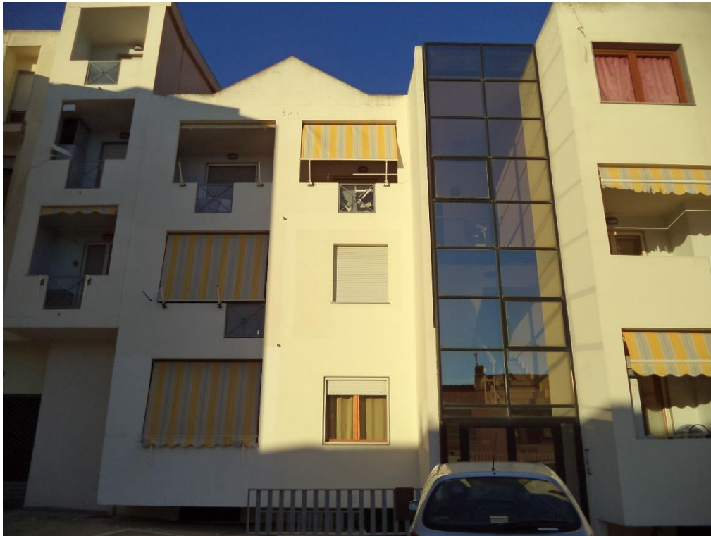
Foto n. 1 - Prospetto interno - Scala di accesso alla cantina
