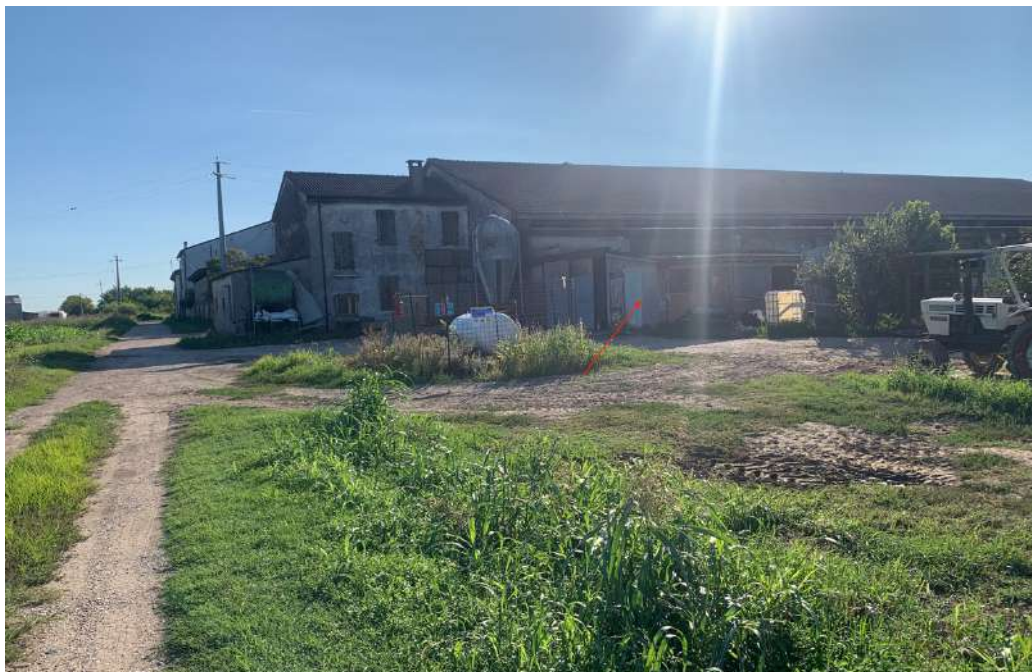
Porzione di stalla non autorizzata
