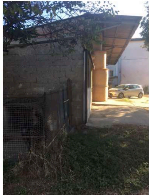
Foto da sopralluogo
