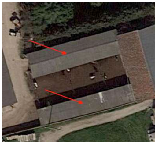
Individuazione delle tettoie non autorizzate
