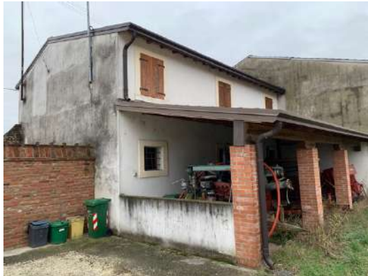
Foto esterni da sopralluogo.
