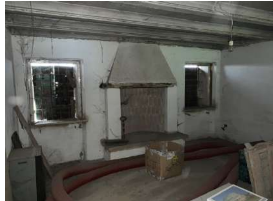
Foto da sopralluogo piano terra
