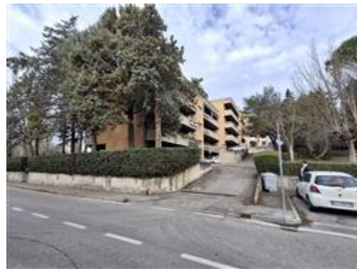
Foto del fabbricato
