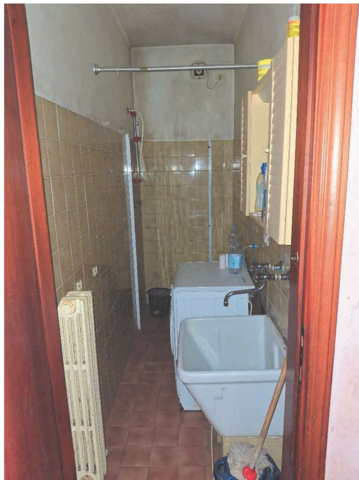
FOTO 10 – BAGNO DI SERVIZIO
