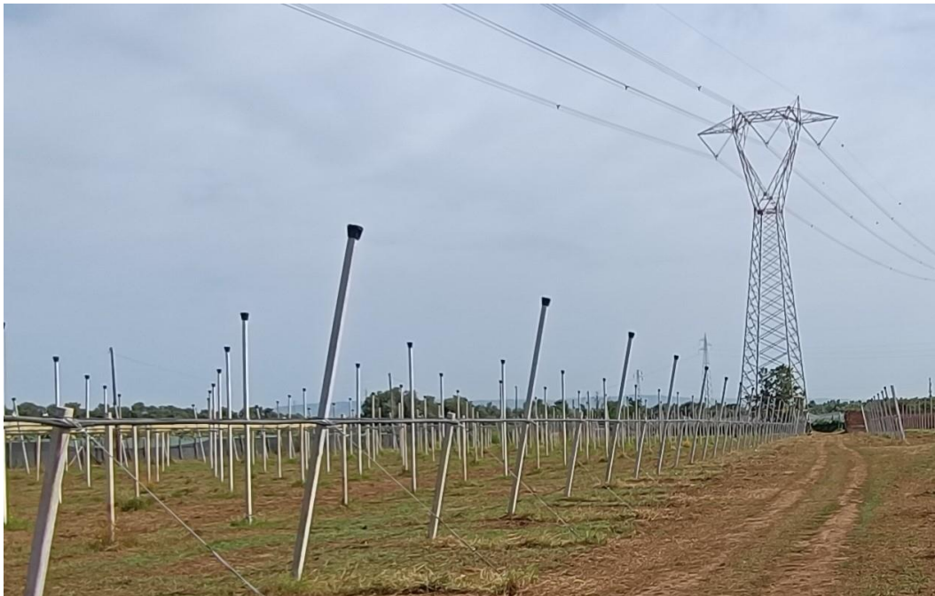
Foto 6: la particella 142 del foglio 40 è interessata dalla presenza di un traliccio dell'alta tensione.
