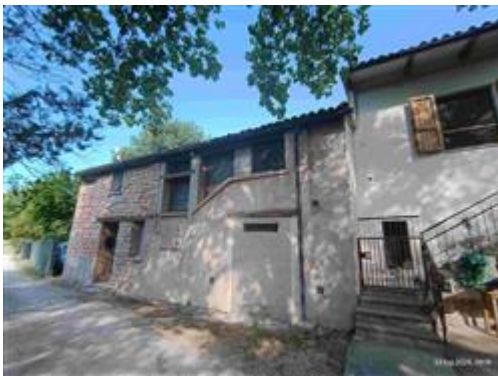
vista facciata di ingresso, lato sud
